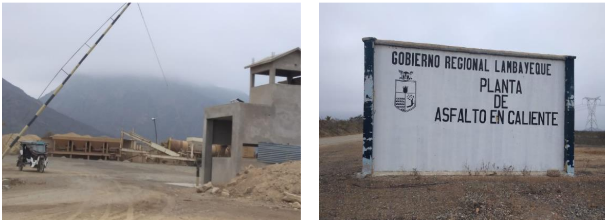
Figura 8. Cantera La Pluma - Batan Grande
