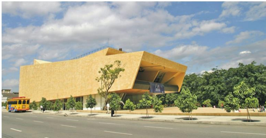
Imagen N°08. Ampliar las actividades astronómicas al exterior como una proyección al aire libre. Recuperado: http://www.arquitecturapanamericana.com/conjunto-parque-de-los-deseos/
