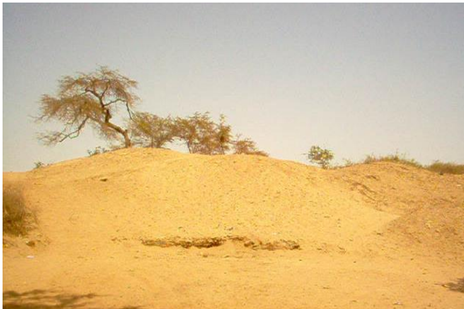
Vista del lado este de la plataforma central de Huaca La Granja. Se muestra la parte central deteriorada por el huaqueo.
