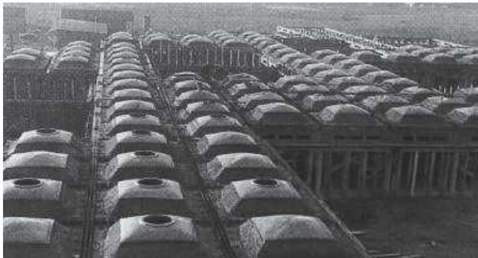
Figura 03. Vista de techos del Orfanato Municipal de Amsterdam.
