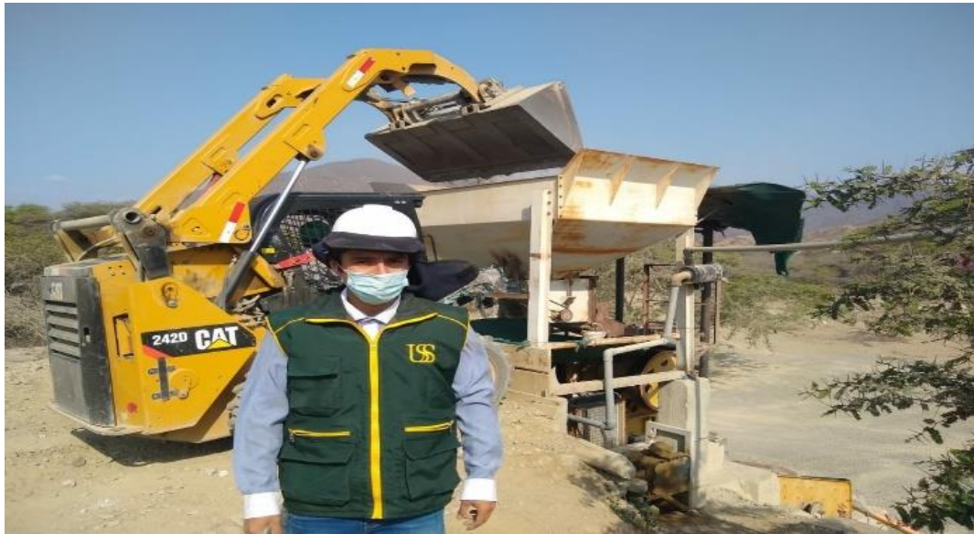
Figura 24:Proceso de llenado de la tolva con agregado reciclado
