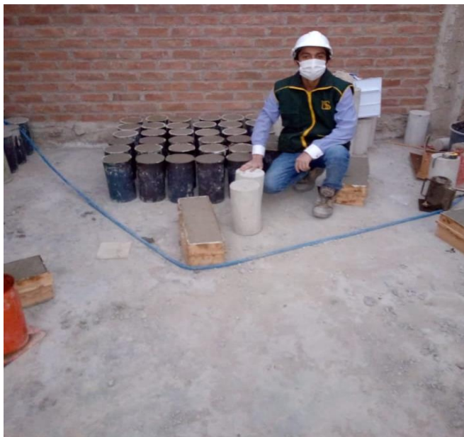
Figura 33: Vaciado de probetas y vigas
