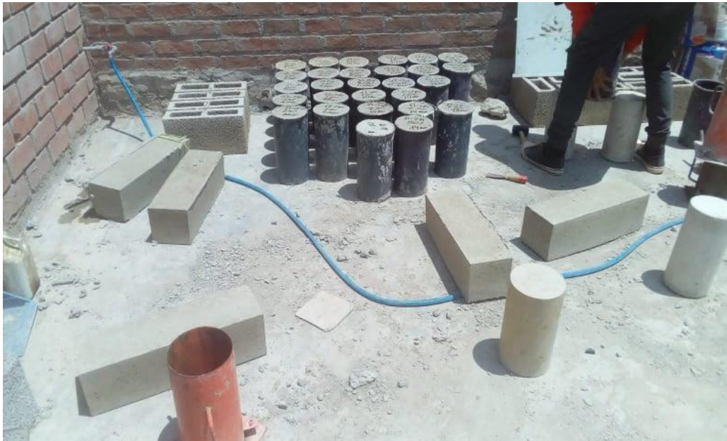
Figura 34: Desencofrado de probetas y vigas
