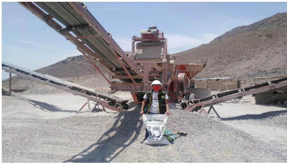
Figura 21: Agregado de la Cantera Zaña - Castro 1
