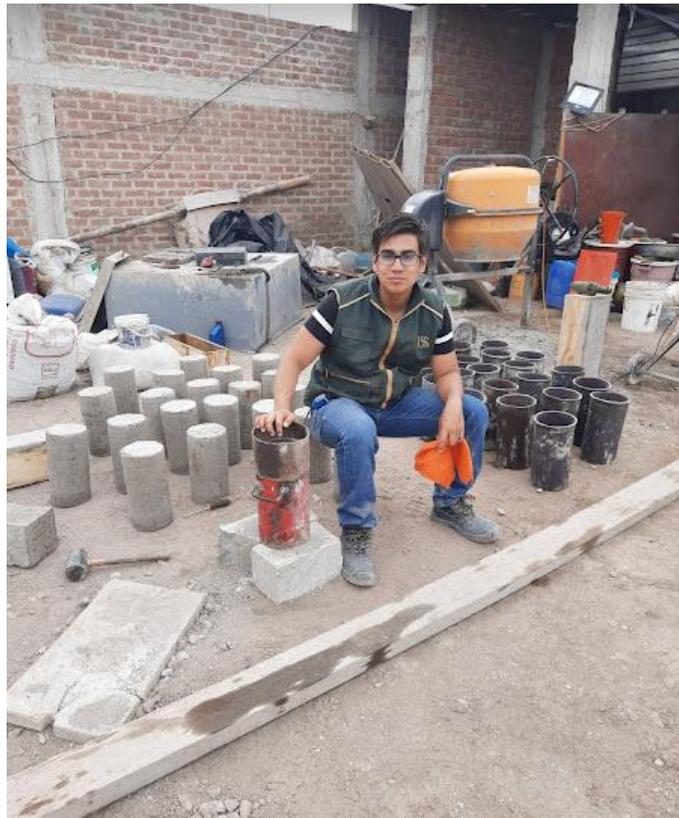
**Figura 43.** Desmolde de probetas y viguetas
