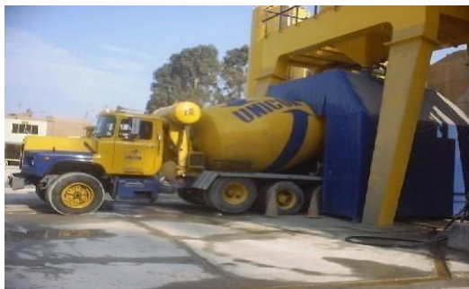
Figura 21. Carga de Insumos para el Concreto Pre-Mezclado
