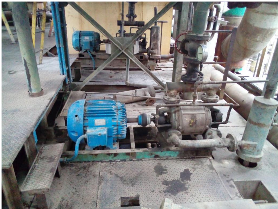
Figura 20. El vacío es la ausencia de presión, y se utiliza para disminuir el punto de ebullición de los fluidos, son accionados por un motor eléctrico de 440 kW. Fuente: Elaboración propia.
