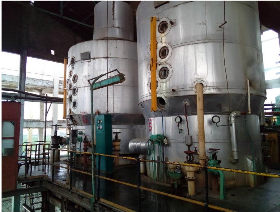
Figura 19. El jarabe es la materia principal con la que se alimenta a los Vacuum panes, los cuales a través del cocimiento forman una masa permitiendo la formación del grano. Fuente: Elaboración propia.
