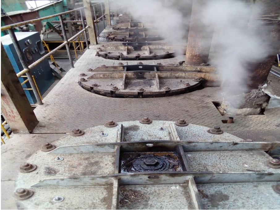
Figura 11. Están constituidos por dos series de 3 equipos y trabajan en paralelo. Fuente: Elaboración propia.
