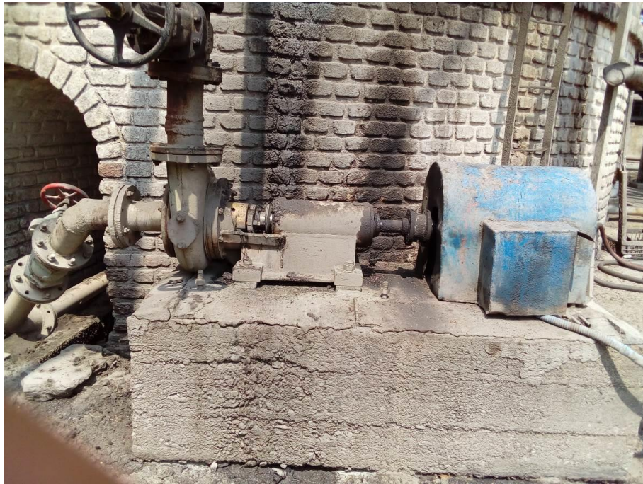
Figura 14. Las bombas utilizadas en el área son de tipo centrífugas y son accionadas por un motor eléctrico con alimentación de 440 kW. Fuente: Elaboración propia.
