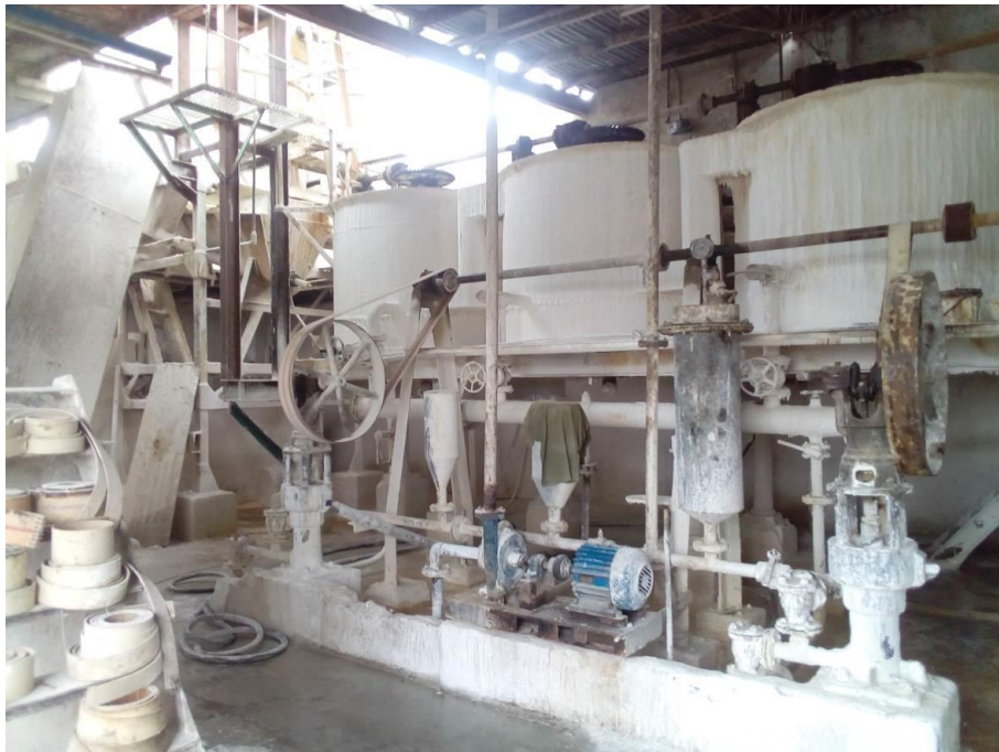
Figura 10. Constituida por un motor eléctrico, un tanque y mecanismos de transmisión. Fuente: Elaboración propia.
