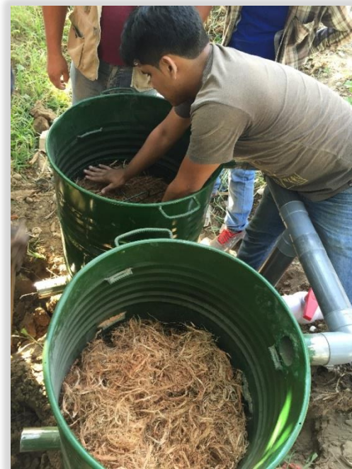
Figura 3.8 Acondicionamiento del medio filtrante
