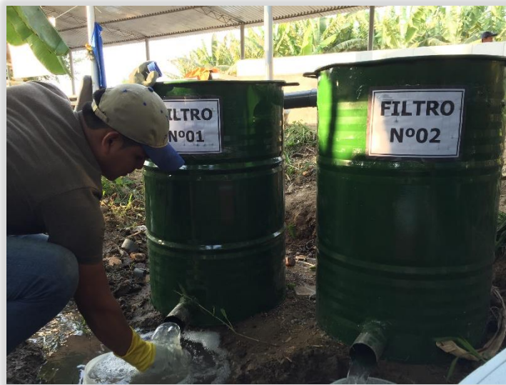
Figura 3.11 Toma de muestras de aguas en la salida de los filtros
