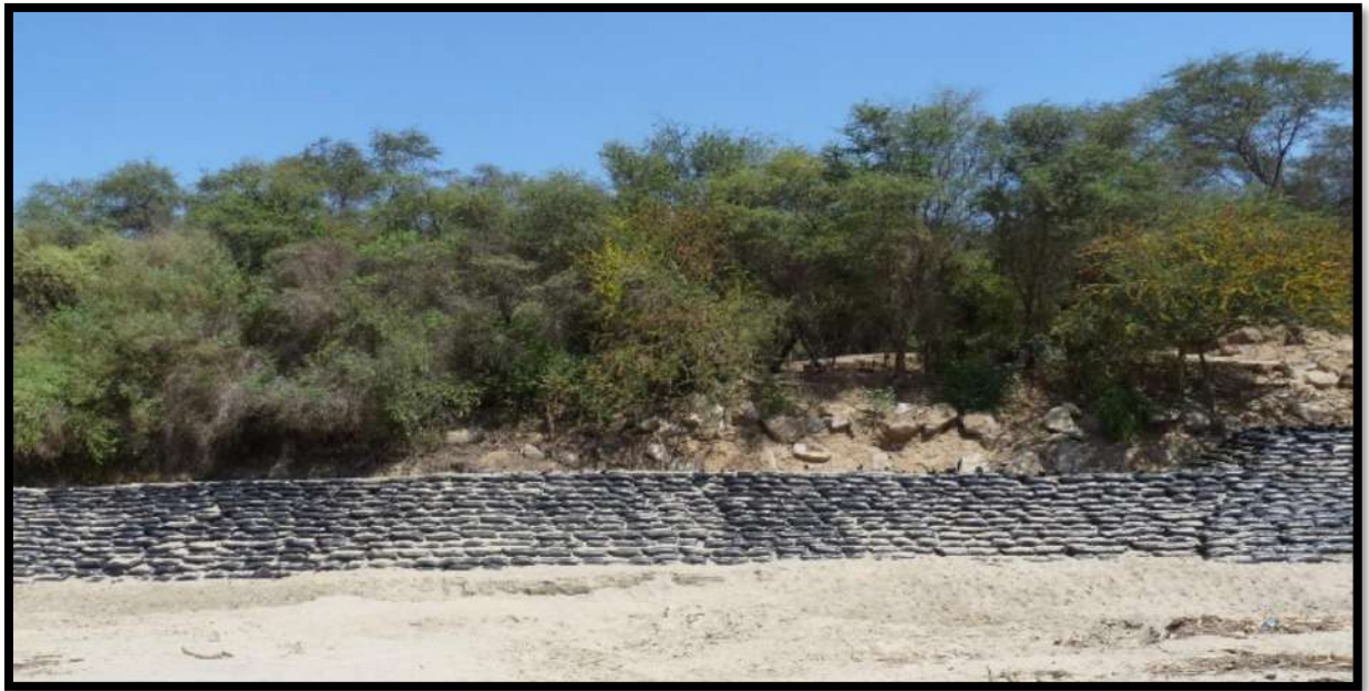
Figura 2: Trabajos de prevención culminados. Fuente: Panel fotográfico obtenido por la UE N° 005 Naylamp Lambayeque.
