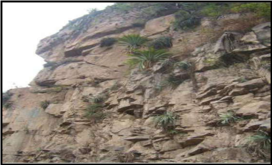
Figura19: Tobas con niveles de cuarcitas muy fracturadas en laderas con fuertes pendiente. Fuente: Foto obtenida del Boletín N° 43 serie C "Riesgo geológico en la región Lambayeque".
