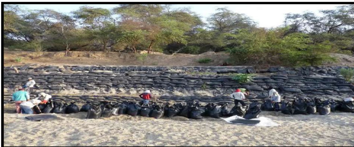
Figura1: Colocación de sacos llenos de arena en el borde del río La Leche, año 2015. Fuente: Panel fotográfico obtenido por la UE N° 005 Naylamp Lambayeque.
