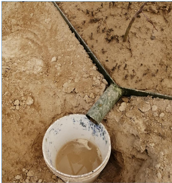
Figura 24 Recolectando el agua con los sedimentos arrastrados
