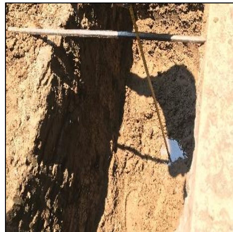
Imagen N° 2 Profundidad de calicata de 1.40 m
