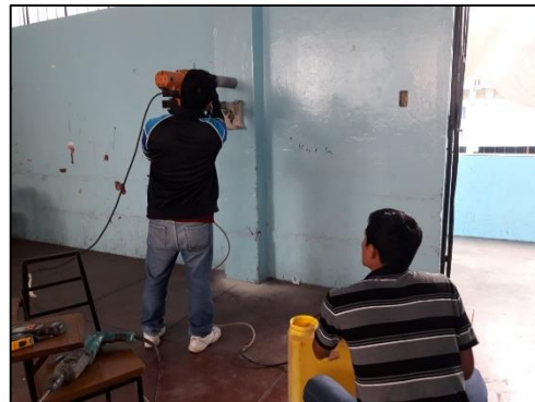
Imagen N° 4 Extracción de corazones diamantinos
