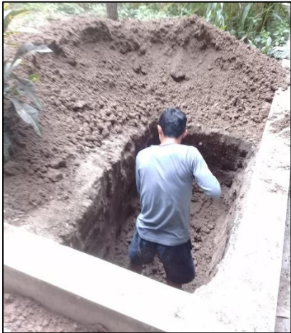
Imagen N° 1: Excavación de calicata
