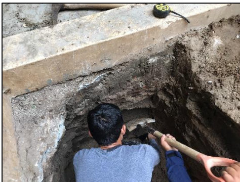
Imagen N° 3 Extracción de muestras
