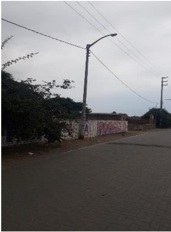
Poste 7-a de tendido de fibra óptica
