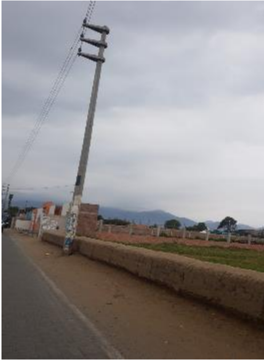
Poste 2-a de tendido de fibra óptica
