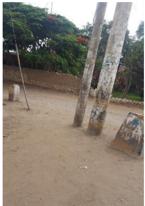
Poste 8-b de tendido de fibra óptica
