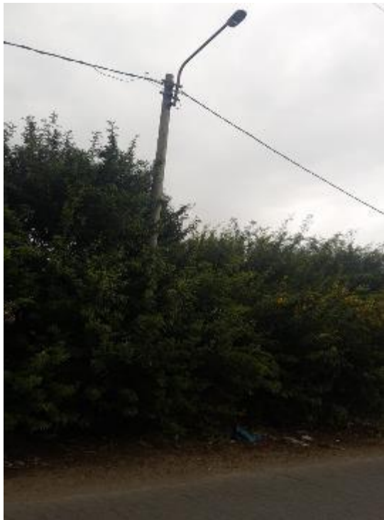
Poste 6-a de tendido de fibra óptica
