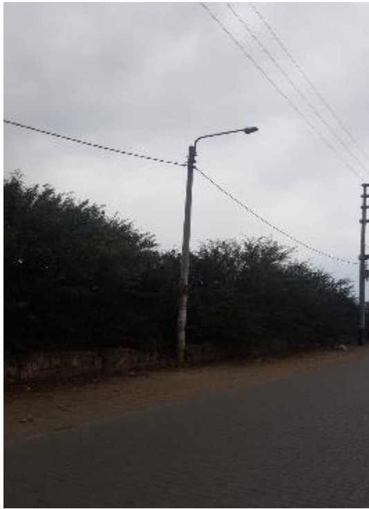
Poste 5-a de tendido de fibra óptica
