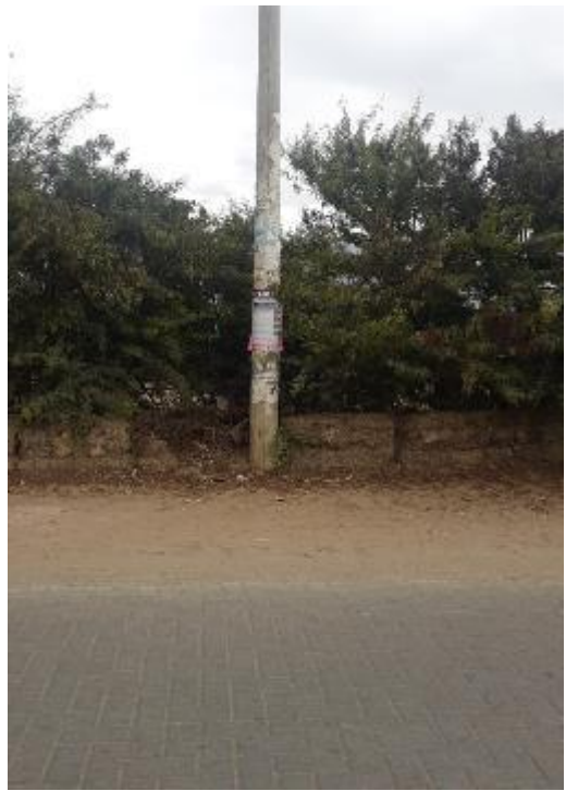
Poste 5-b de tendido de fibra óptica
