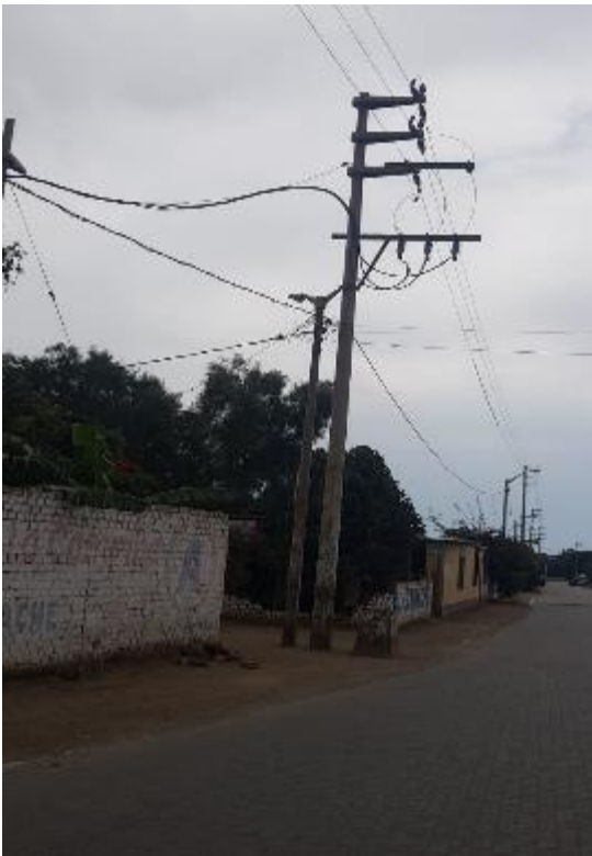
Poste 8-a de tendido de fibra óptica
