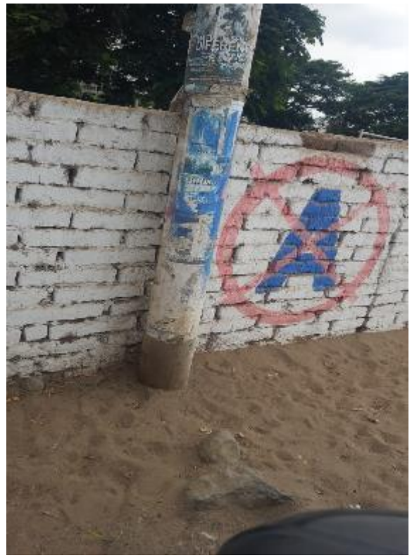
Poste 7-b de tendido de fibra óptica
