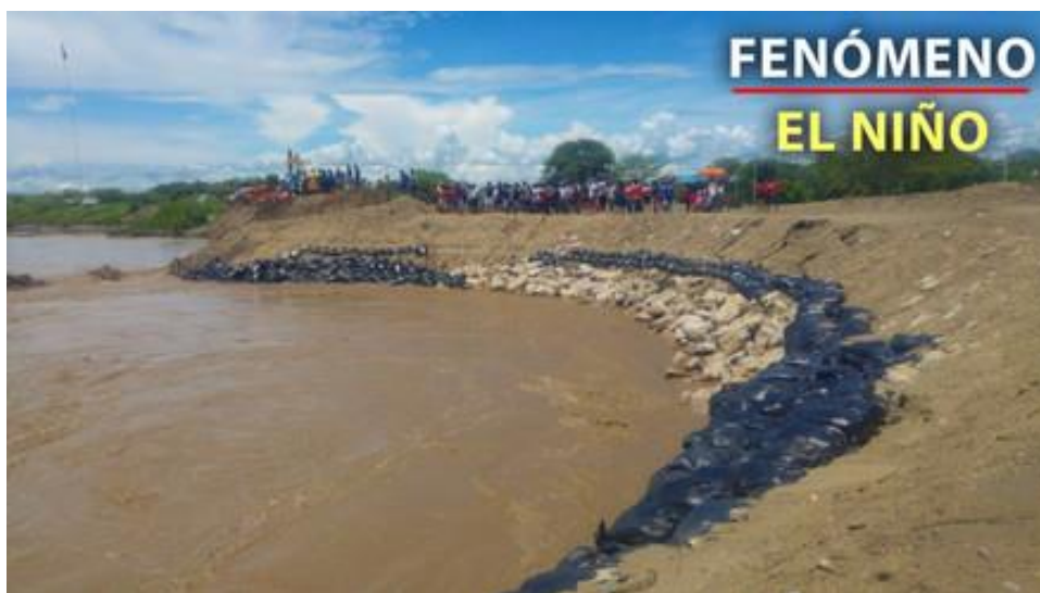
Figura 4: Río cascajal se desbordó e inundó 80 viviendas de los caseríos de olmos.
