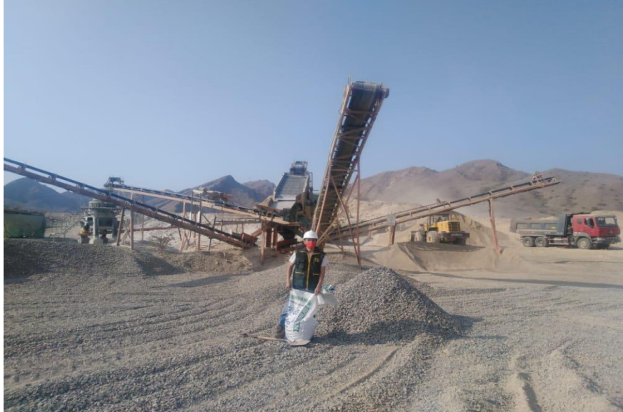
Fotografía 1: Agregado grueso Cantera Ferreñafe - Tres tomas
