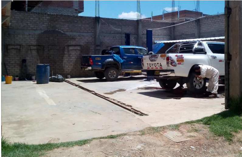
Figura 11. Imagen de patio de trabajo del taller Escor Automotriz, donde se observa la falta de señalización, depósitos en lugar inadecuado, falta de parrilla de canaleta y falta de techo.
