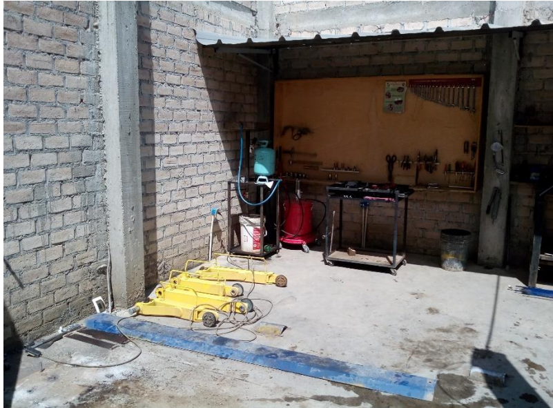
Figura 13. Imagen de zona de trabajo, equipos y herramientas sin orden, falta de control visual de herramientas, materiales tirados en la zona de trabajo, zona de trabajo sin señalética.
