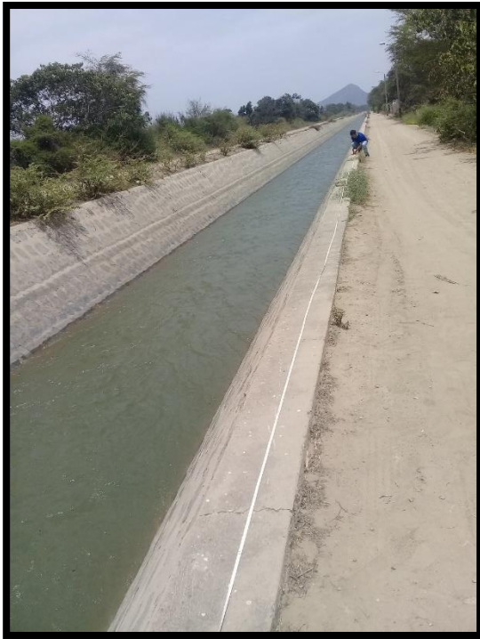
Figura 23: Estableciendo las medidas de los caudales en el punto del tramo, fuente (elaboración propia)
