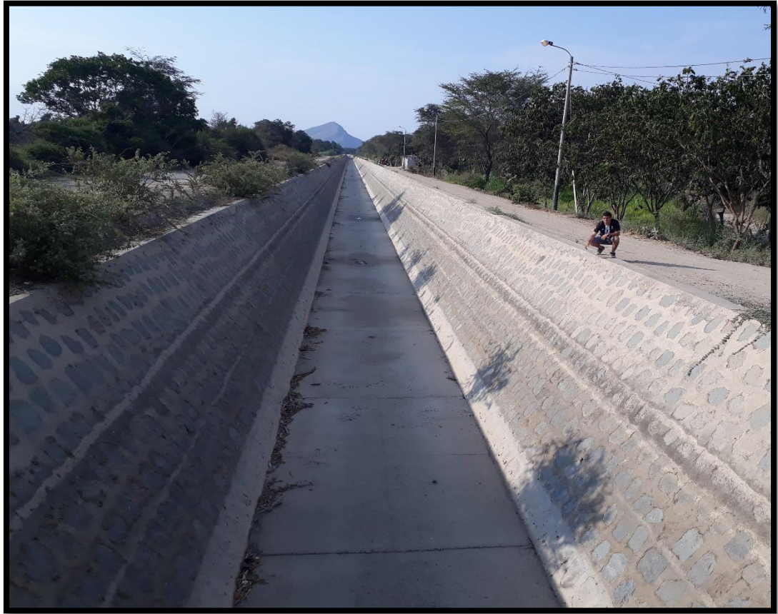
Figura 7: Canal artificial Taymi de sección Trapecial, fuente (elaboración propia)
