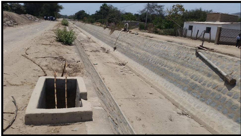
Figura 58: en este tramo observamos el tipo de material de construcción y la ausencia de barandas, fuente (elaboración propia)
