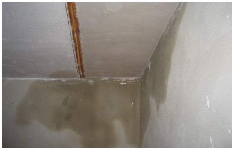
Figura 22 Humedad en edificaciones
