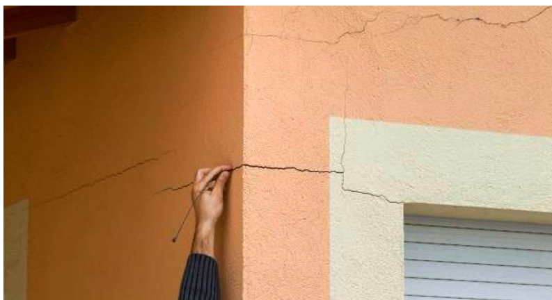
Figura 24 Humedad en edificaciones
