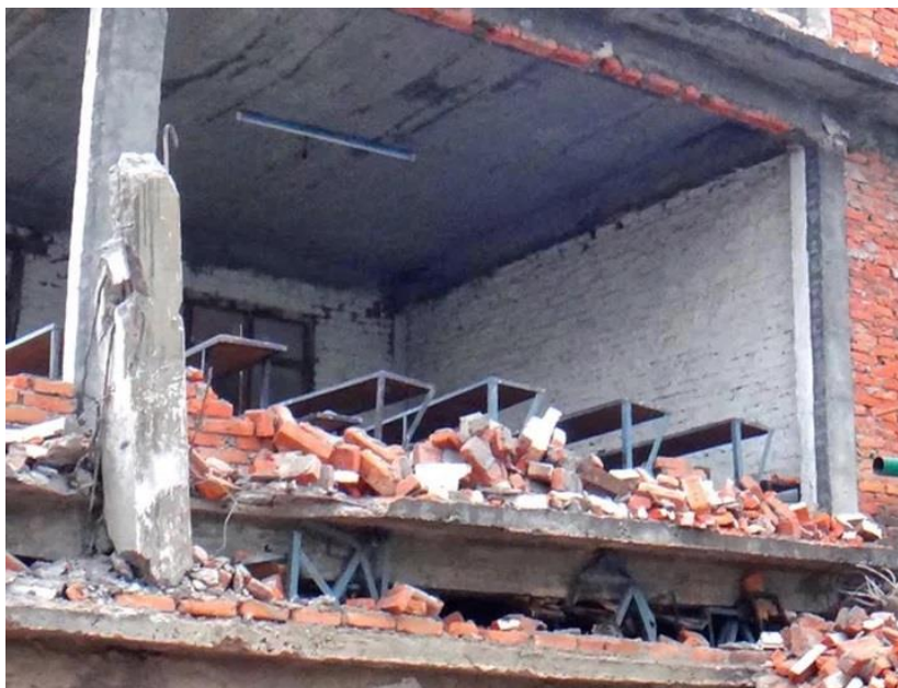
Figura 2 Ambiente de edificio escolar después de ocurrido un terremoto Colapso de muros de un ambiente escolar en Nepal después de un terremoto.
