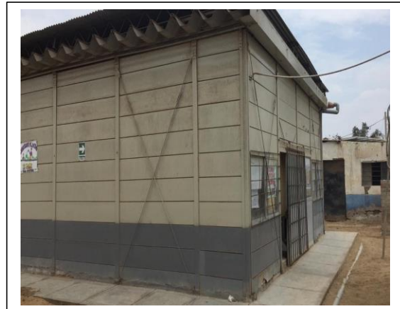
Figura 81: Aulas prefabricadas I.E N° 11243 Fuente: Elaboración propia
