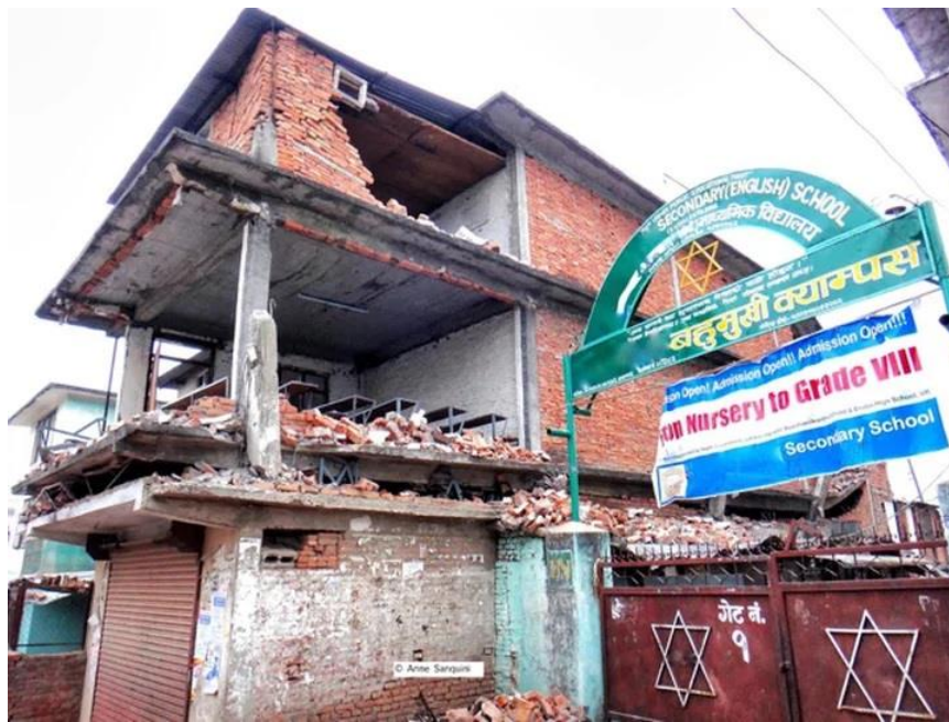
Figura 3 Edificio escolar colapsado Edificio escolar colapsado luego de terremoto.
