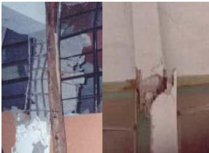
Figura 16 Fallas producidas por columna corta
