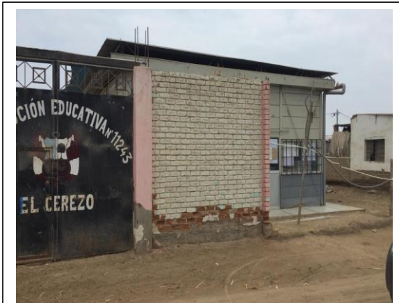
Figura 80: Fachada de la I.E N° 11243 Fuente: Elaboración propia
