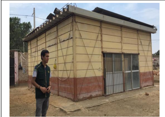
Figura 82: Almacén prefabricado I.E N° 11243 Fuente: Elaboración propia
