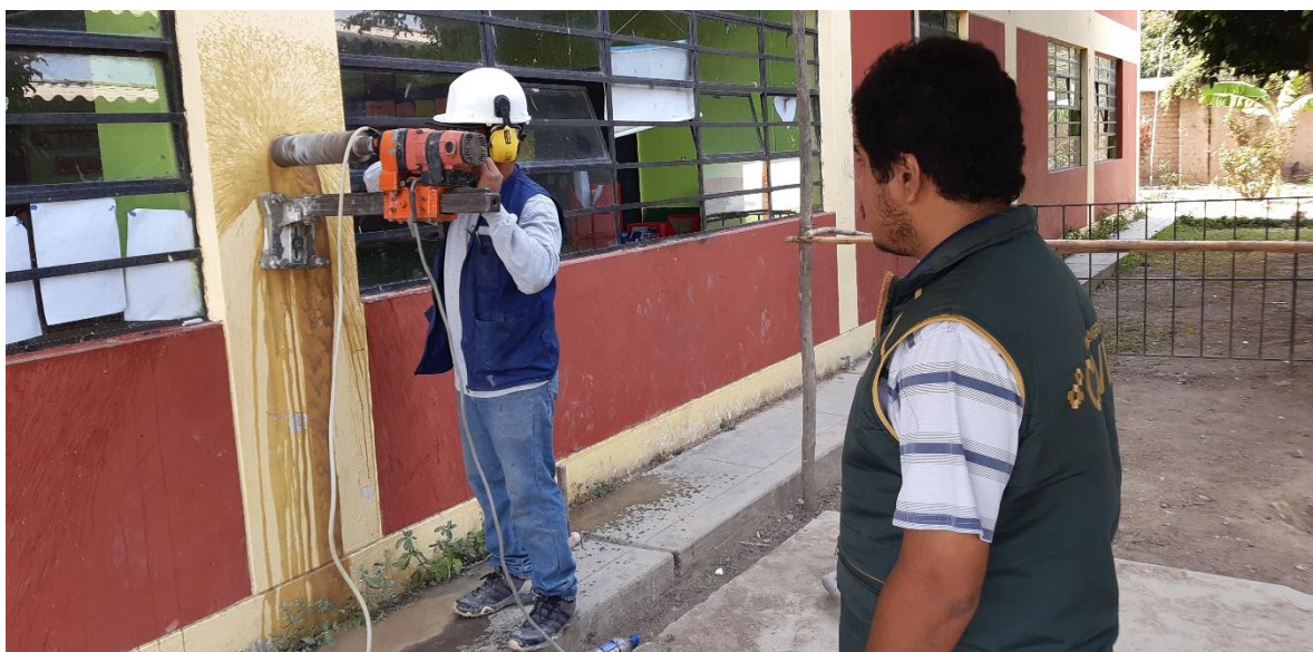
Ilustración 47: Extracción de corazones diamantinos en el módulo de aulas en la IE. N° 10007
