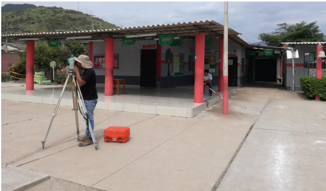
Ilustración 27: Levantamiento topográfico de los módulos de la IE. N° 10006
