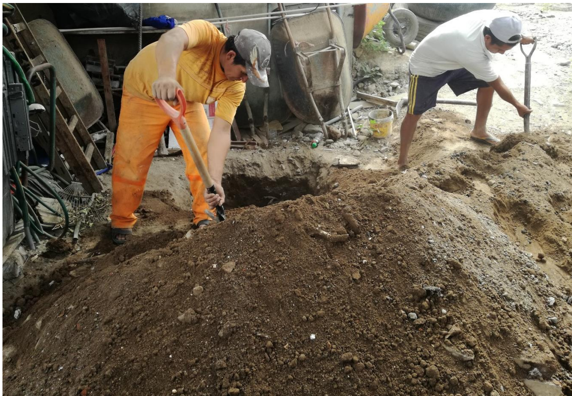
Ilustración 31: Material extraído calicata N°1, relleno no seleccionado
