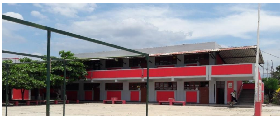
Ilustración 22: Módulo de aulas de concreto armado de la IE. N° 10006
