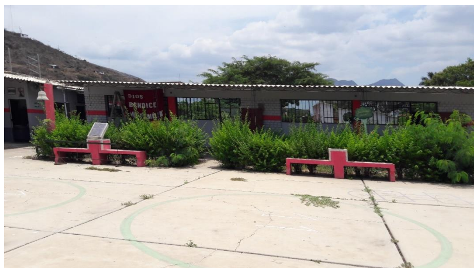
Ilustración 23: Primer pabellón de la I.E.N°10006
