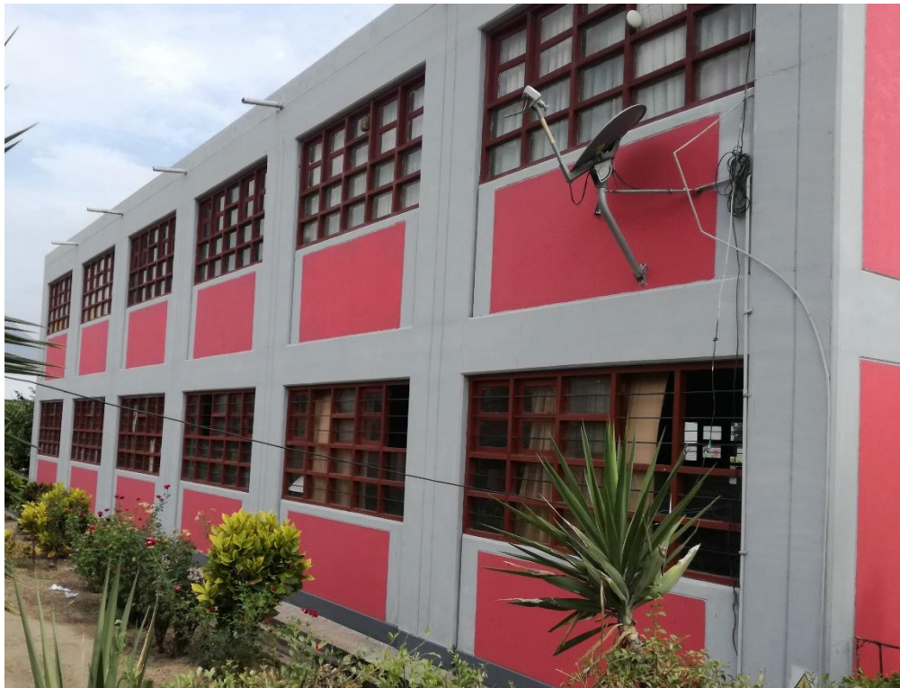
Ilustración 24: Exterior posterior del módulo de aulas de la IE. N°10006
