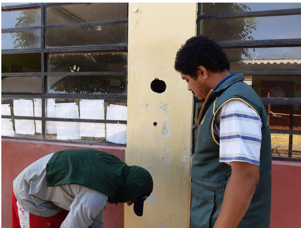
Ilustración 49: Reparación de daños por la extracción de corazones diamantinos
