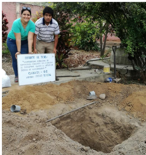
Ilustración 33: Calicata N°2 de la IE. N° 10006
