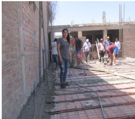
**Figura 92:** Se observa el vaciado de la viga .
