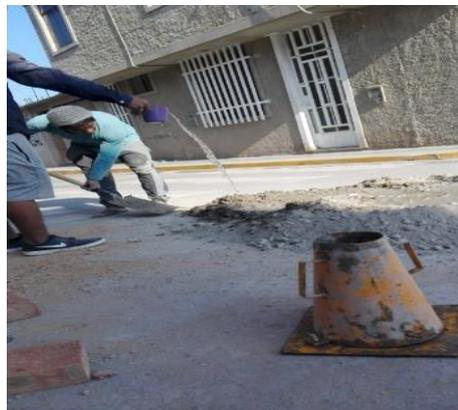
**Figura 54:** Se observa el mezclado se hace manualmente la cual no hay una buena combinación de agregados.
