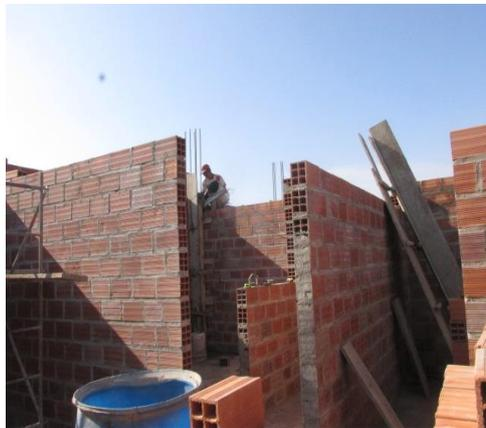
**Figura 72:** Se observa el llenado de la columna.
