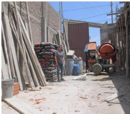
**Figura 94:** El mezclado se realiza con trompo lo cual hay una buena combinacion de materiales.
