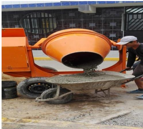
**Figura 48:** Preparación de concreto uso de la mezcladora
