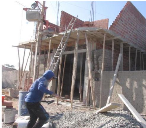
**Figura 74:** Se Obseva el llenado de la columna segundo nivel.
