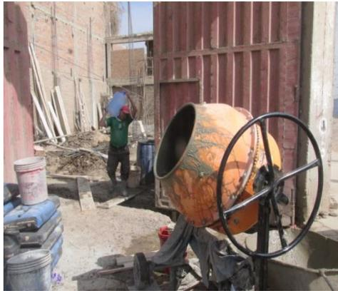
**Figura 77:** El mezclado se realiza con el uso del trompo.
