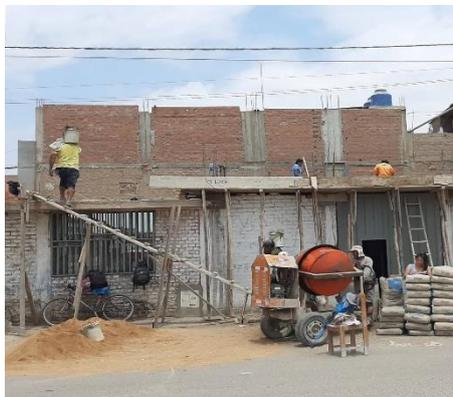
**Figura 90:** El mezclado se realiza en trompo.
