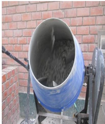
**Figura 105:** Se muestra trompo mezclador co todos los agregados .
