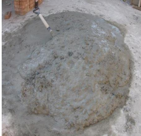
**Figura 59:** Forma de mezclado manualmente.
