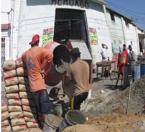
**Figura 67:** Forma de mezclado con trompo.
