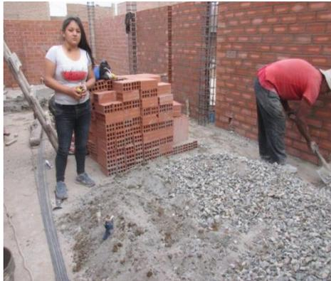
**Figura 85:** El mezclado se realiza manualmente lo cual no genera una buena combinación de materiales.
