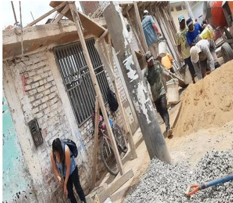
**Figura 89:** Se observa el vaciado de viga.
