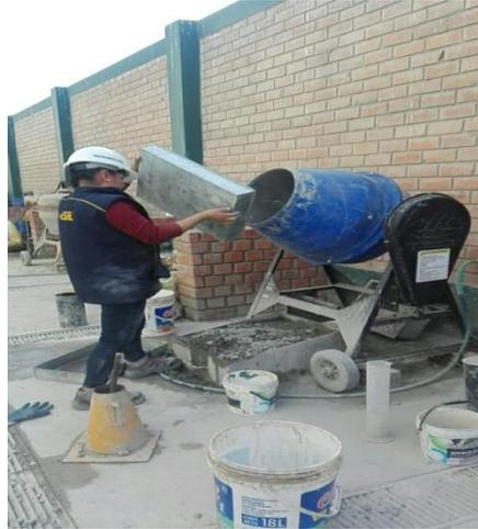
**Figura 104:** Se muestra trompo mezclador donde se procede la colocación de todos los agregados
