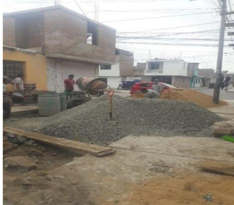
**Figura 57:** El mezclado se realiza con trompo.
