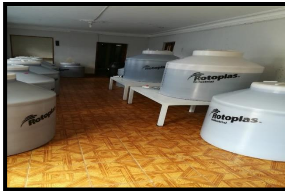
Figura 31: Zona de clarificación
