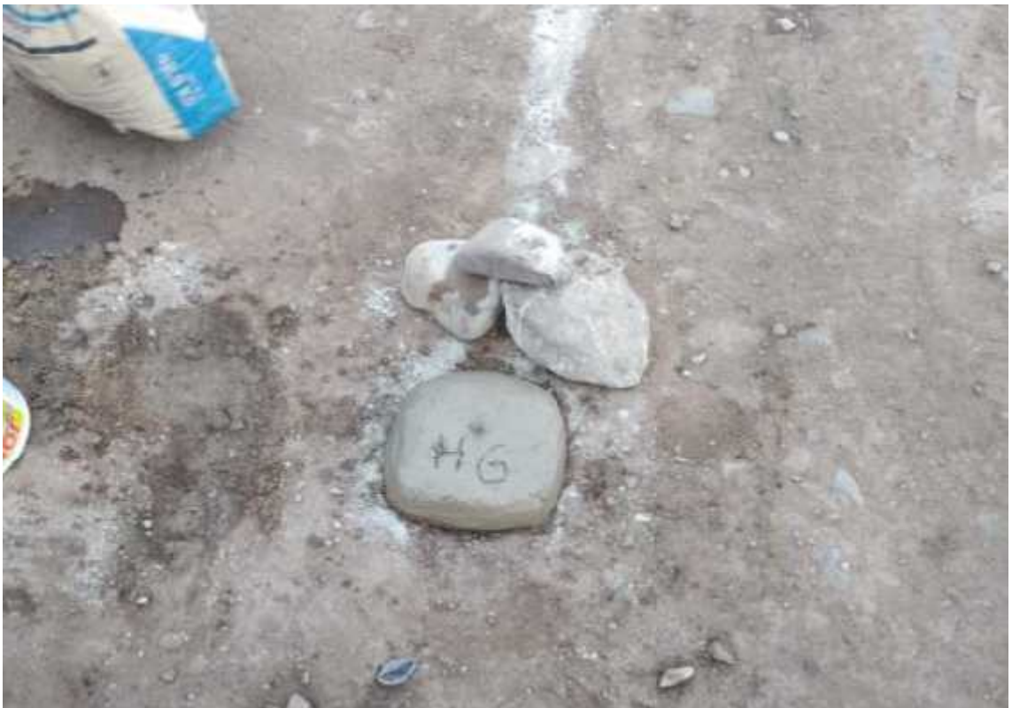
Foto N°04.- Colocación de BMS de control del levantamiento topográfico
