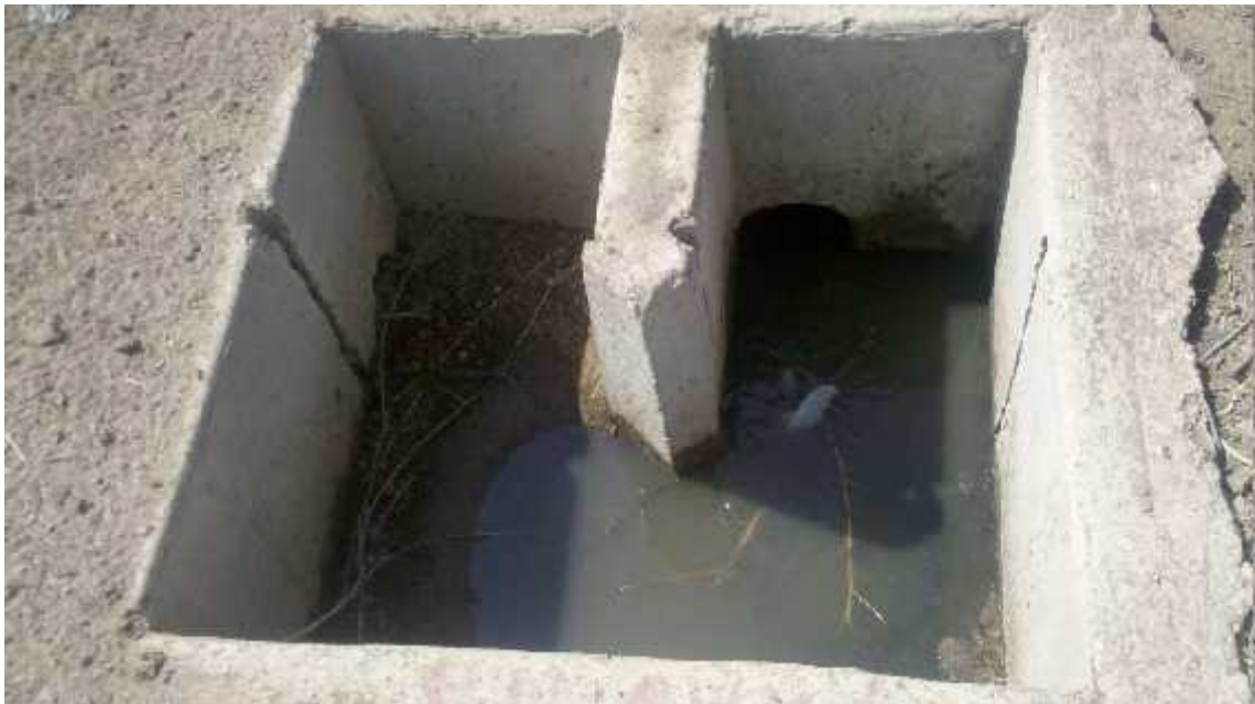
Vista estructura de ingreso a laguna existente zona urbanización
