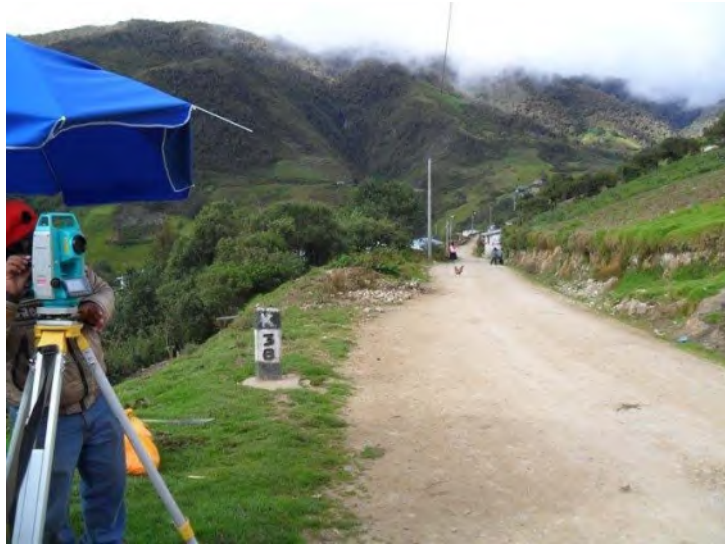
Estación total y topógrafo tomando medida a lo largo de la carretera.
