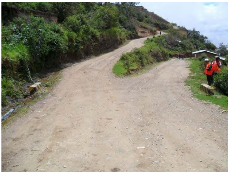
Ayudante con prisma tomando medidas sobre la carretera.
