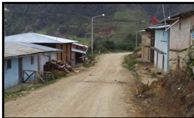
Imagen 1. Vista panorámica material de viviendas del caserío “Huanacaure”.
