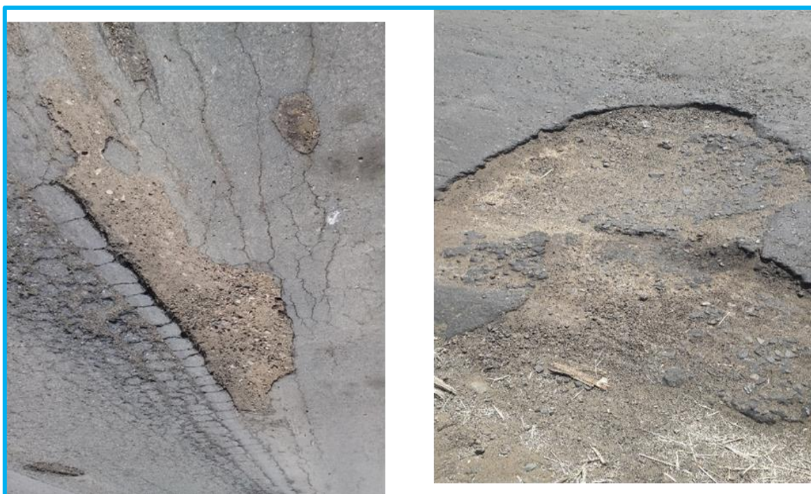
Fotografía 01: Deterioro en el paquete estructural del pavimento observando baches medios.
