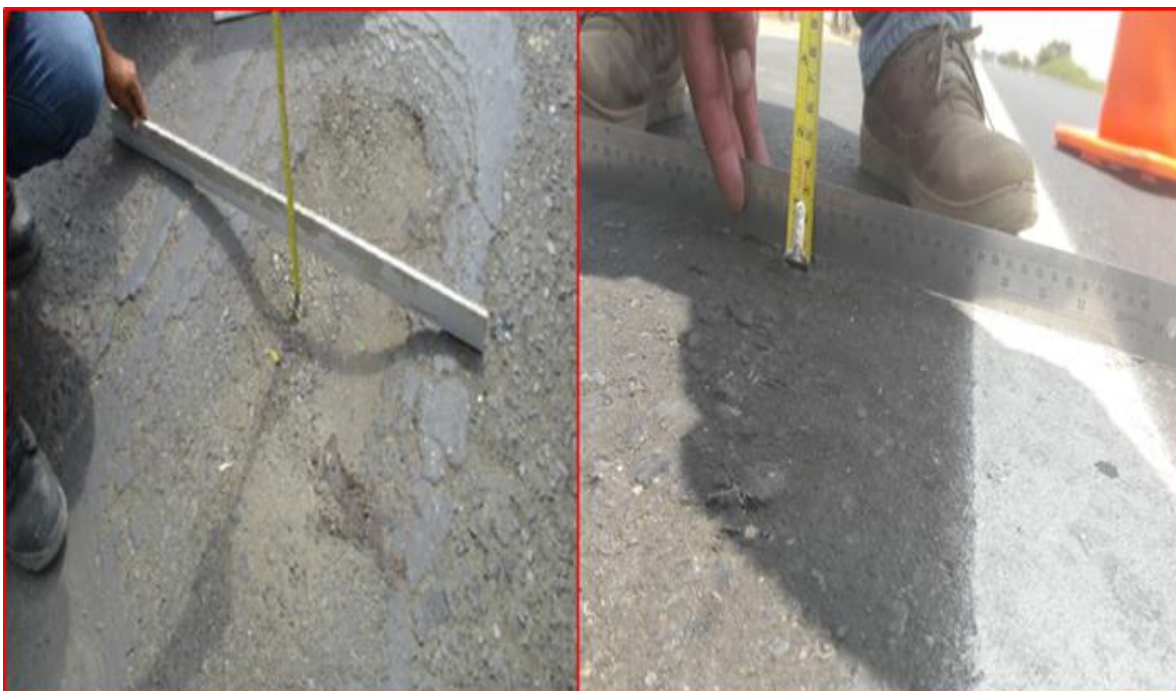
Fotografía 03: Hundimiento pequeño producido por la acumulación de material en la fisura en combinación con cargas de tráfico.
