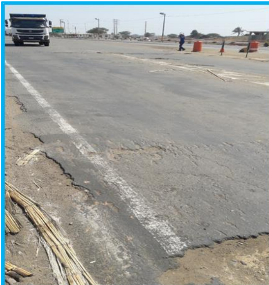
Fotografía 04: Parche medios y altos con desprendimiento de agregados intermedio.
