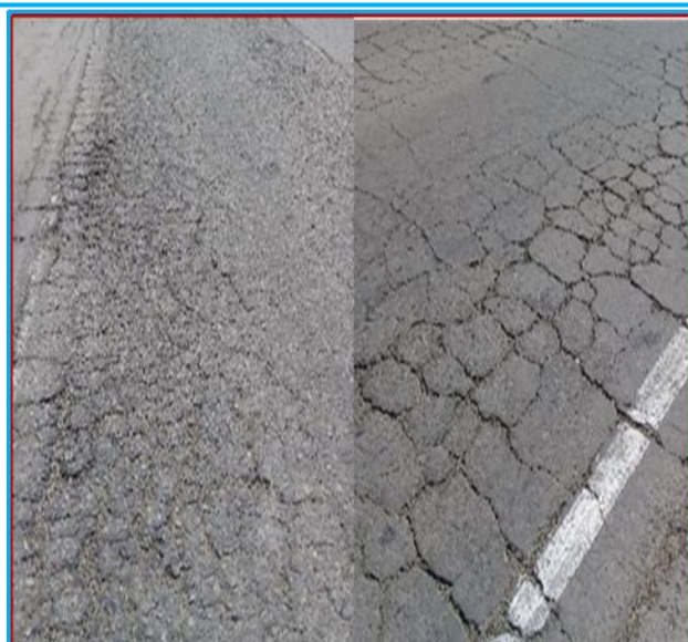
Fotografía 05: Existencia de baches medios con presencia de piel de cocodrilo en el pavimento y fisuras longitudinales altas.
