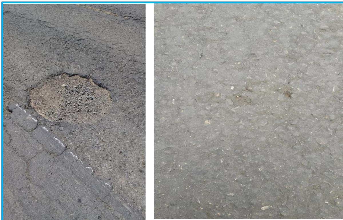
Fotografía 08: El pavimento presenta agregado pulido medio.
