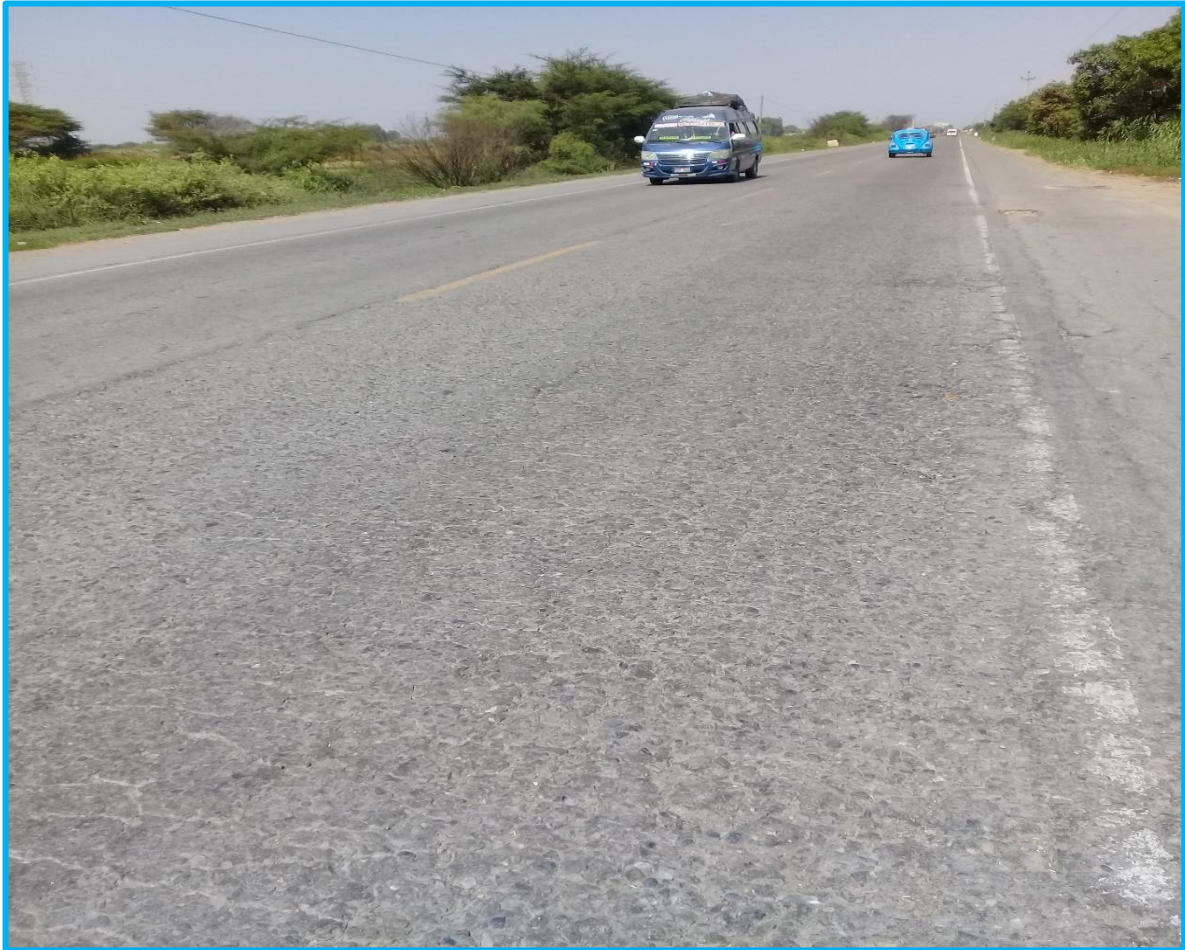
Fotografía 06: Parche medios y altos con desprendimiento de agregados intermedio.
