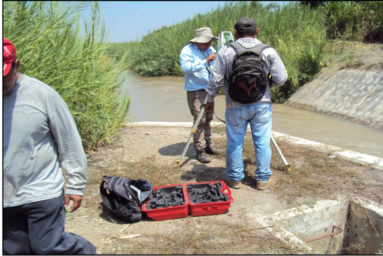
Topógrafo instalando Estación Total Leica FlexLine Ts02. . canal Chiclayo.
