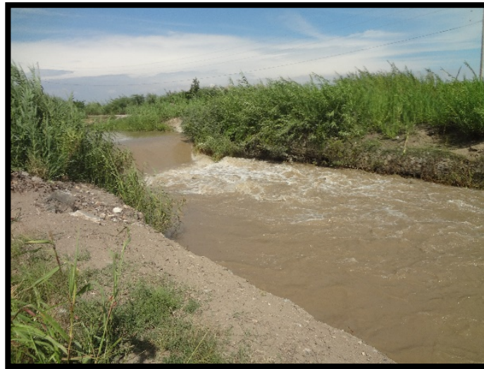
FOTO N°2: EN LA 0+080.59 EXISTE UNA ESTRUCTURA (CAÍDA) EN BUEN ESTADO, EN MATERIAL DE MAMPOSTERÍA.
