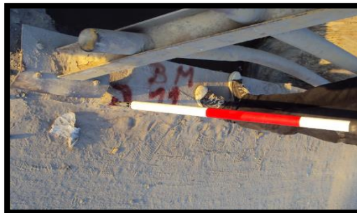
Figura 13: BM final N° 11 en puente de salida a Pomalca.
