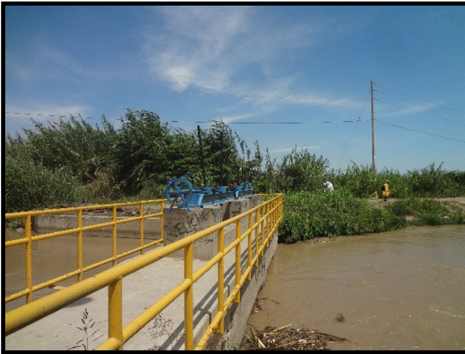
FOTO N°1: Inicio del canal Chiclayo, progresiva 0+000, Partidor Chéscope.
