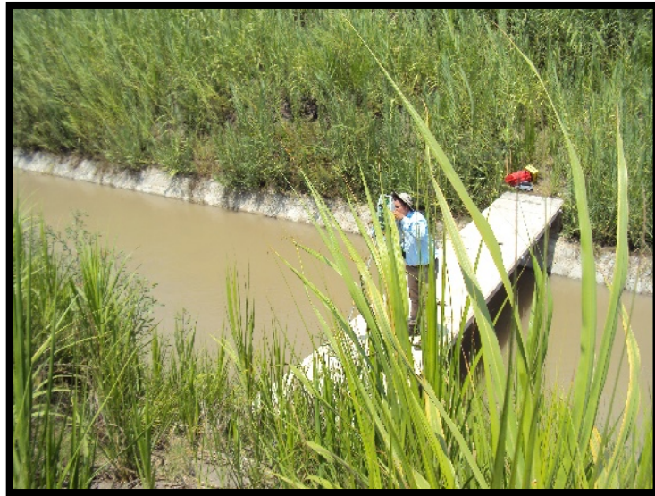
FOTO N°4: EN LA PROGRESIVA KM: 0+245.02 EXISTE UNA PASARELA PEATONAL EN BUEN ESTADO
