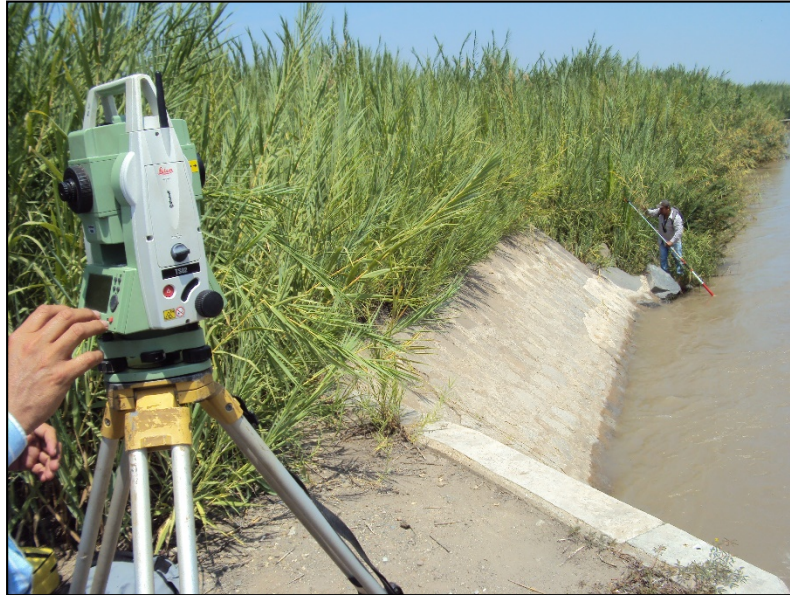
Topógrafo ingresando Coordenadas Estación Total Leica FlexLine Ts02. canal Chiclayo.
