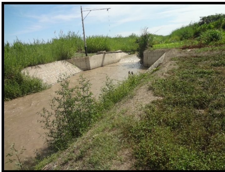
FOTO N°3: EN LA PROGRESIVA 0+136. EXISTE UNA ESTRUCTURA (MEDIDOR PARSHALL) EN BUEN ESTADO.
