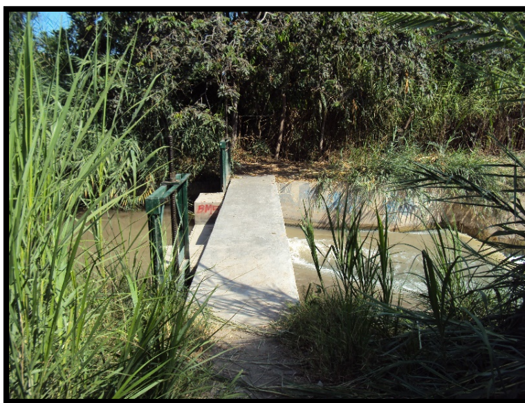
FOTO N°4: EN LA PROGRESIVA 4+520 SE ENCUENTRA LA TOMA DE RETENCIÓN CHILAPE.
