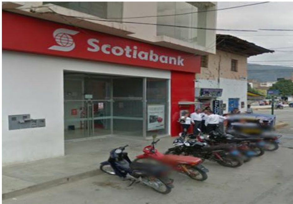
Figura 33. Instalaciones del banco (fachada)
