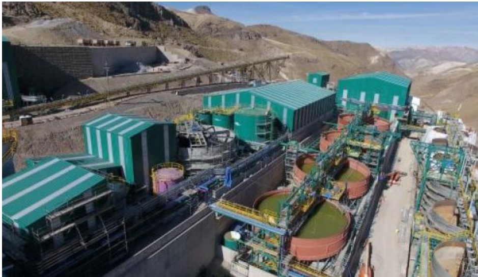
Figura 11: Vista panorámica Planta de procesos Tambomayo, (DIARIO GESTIÓN, 2017)
