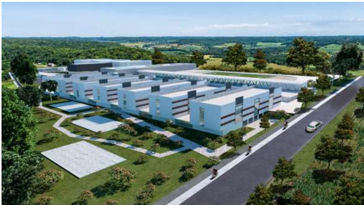
Figura 50. Vista de zona residencial (Pabellones de dormitorios) Fuente: Elaboración Propia 3D
