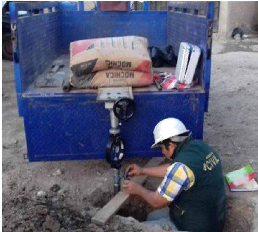
Fotografía N° 7 – Colocación del dial de penetración
