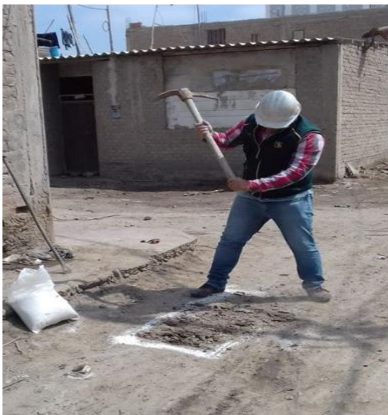
Fotografía N° 2 – Excavación de la calicata
