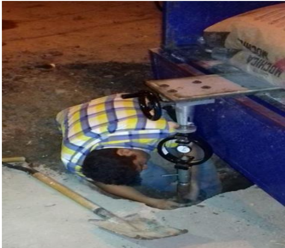
Fotografía N° 10 – Colocación del pistón
