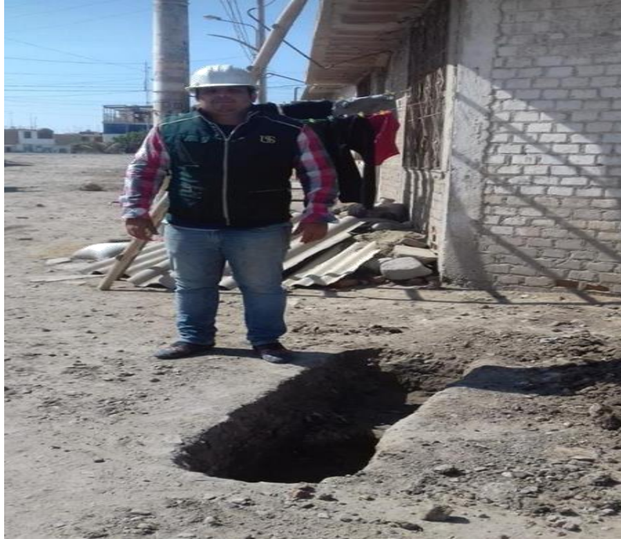
Fotografía N° 5 – Nuevo punto de excavación de calicata
