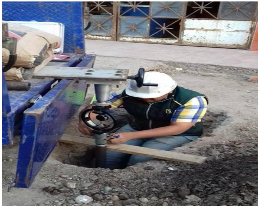
Fotografía N° 8 – Colocación del Dial de fuerza
