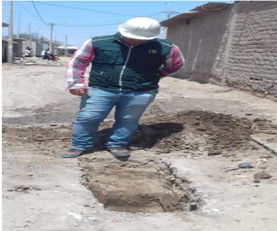
Fotografía N° 3 – Verificación de la profundidad de la calicata
