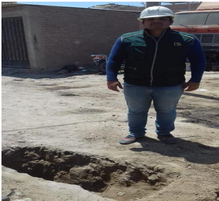
Fotografía N° 4 – Excavación de calicatas escalonada de 20, 40 y 60 cm.
