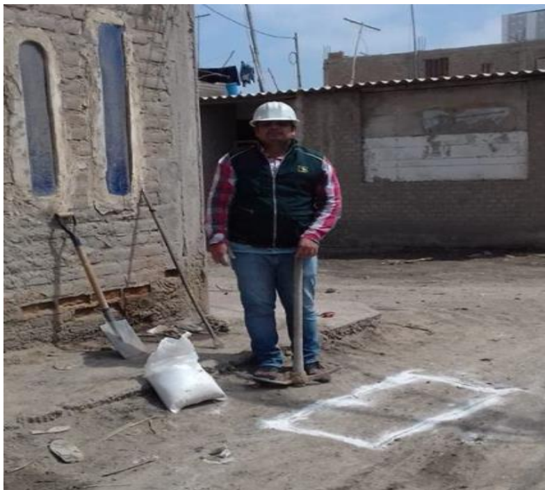
Fotografía N° 1 – Se enmarco la ubicación de la calicata
