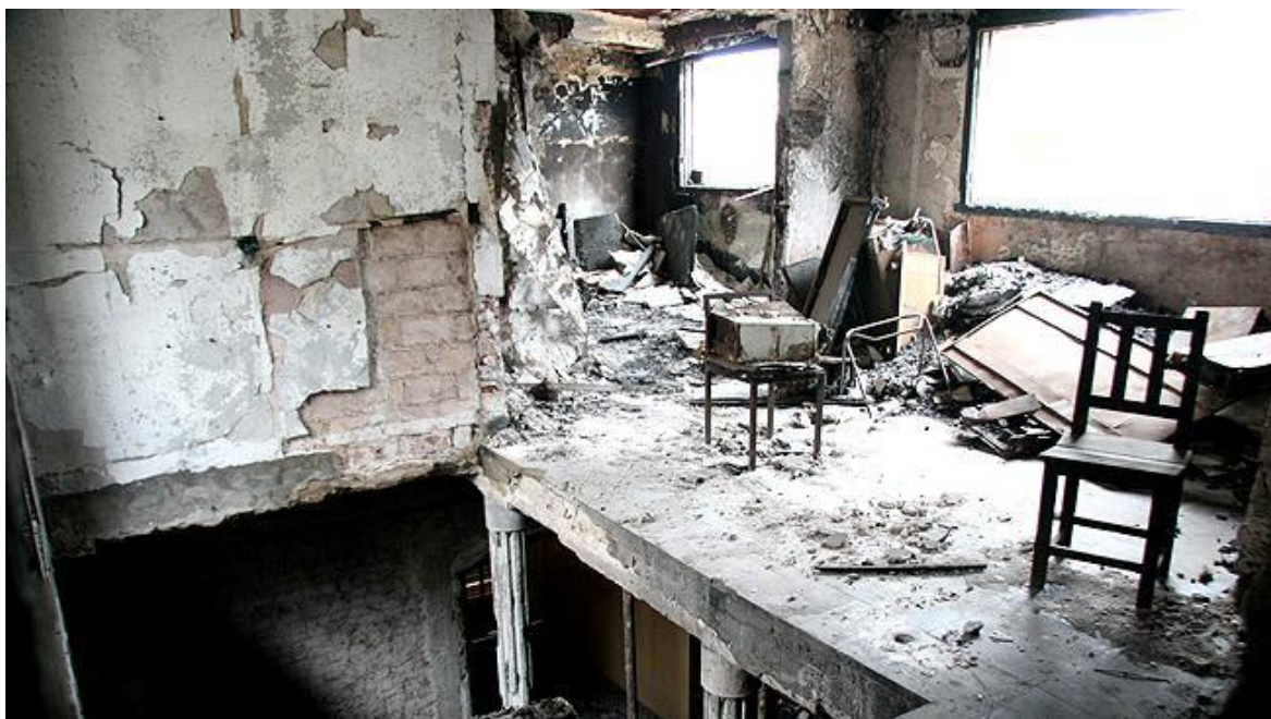
Imagen 15. Incendio en un CPD
