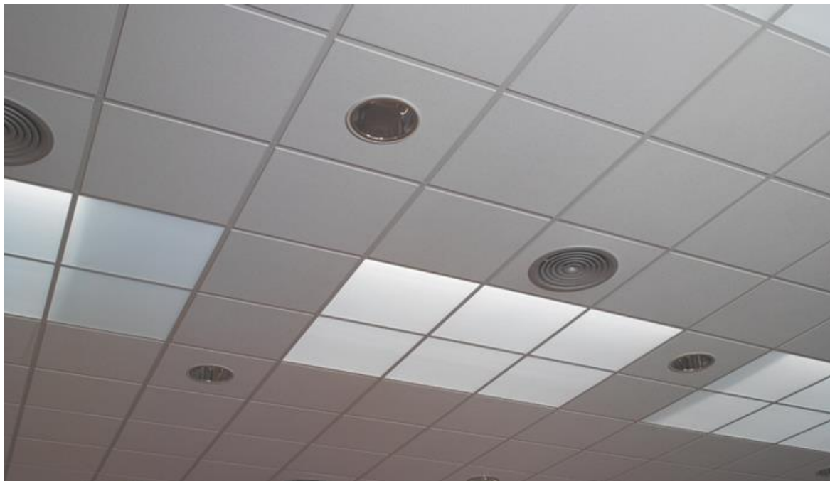
Figura 17. Iluminación en un CPD
