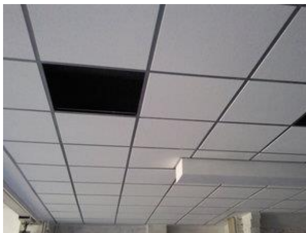
Figura 20. Falso techo dentro del CPD
