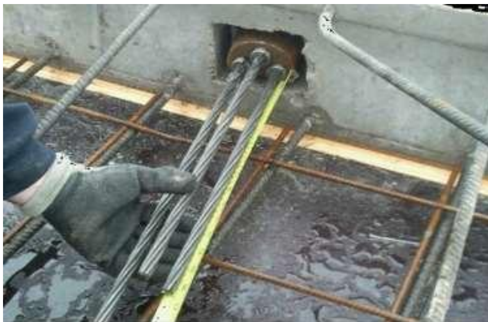
Figura 16. Sellado de Ductos y accesos en un CPD
