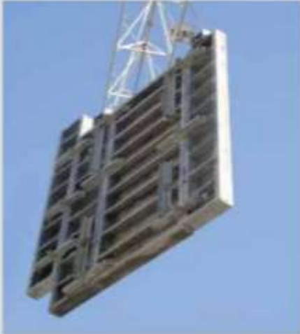
Paneles de madera 1.25 x3.5 m t de altura
