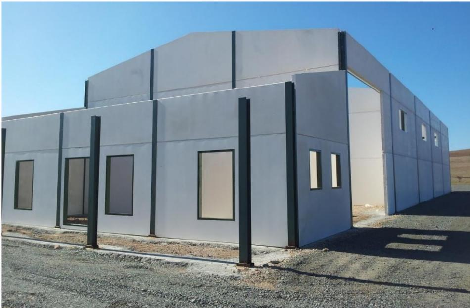
**Figura N° 05:** Paneles de fachadas de viviendas.
