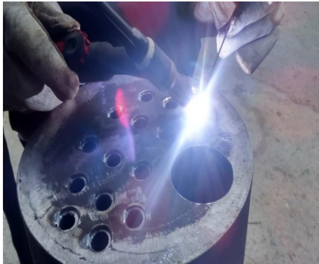
Ilustración 64 Construcción del haz de tubos.
