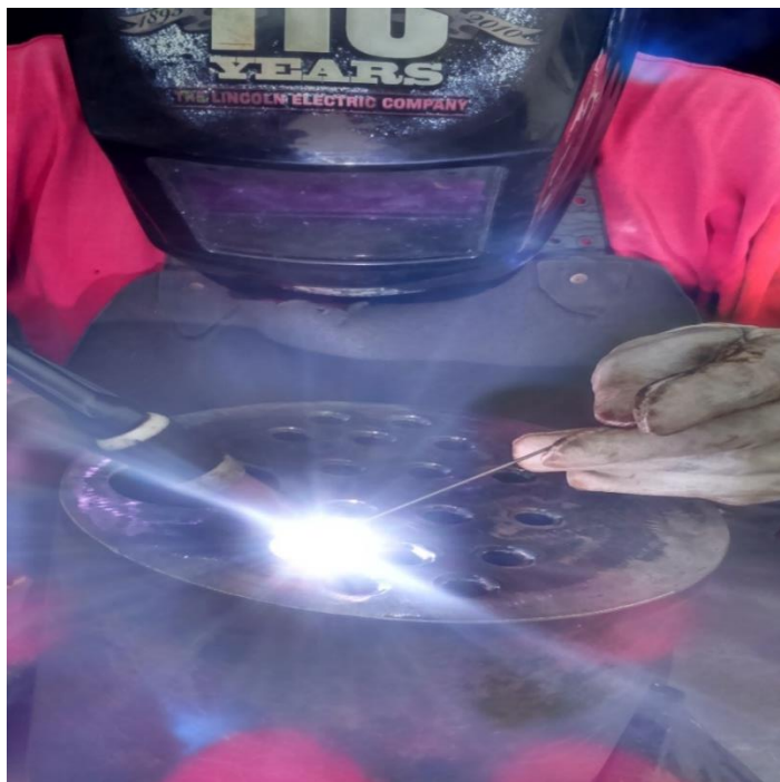
Ilustración 65 Soldadura del haz de tubos.
