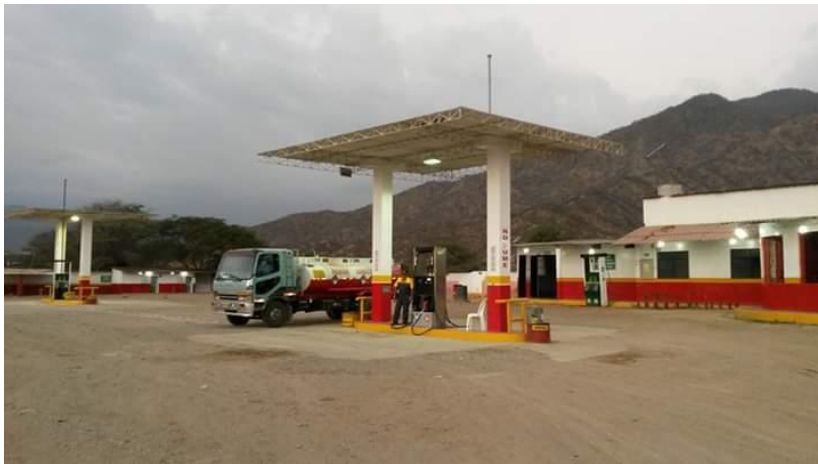
Figura 6. Foto de la empresa “Estación de Servicio San Francisco SRL”
