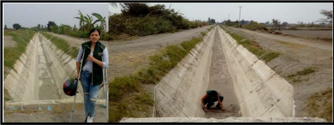
Figura 20. Aforación del Canal Chucupe.
