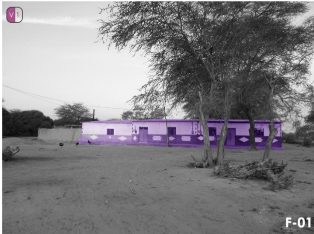
F-01 VIVIENDA DE ADOBE 01 NIVEL
