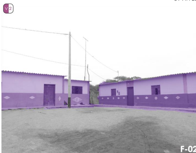
F-02 VIVIENDA DE ADOBE 01 NIVEL
