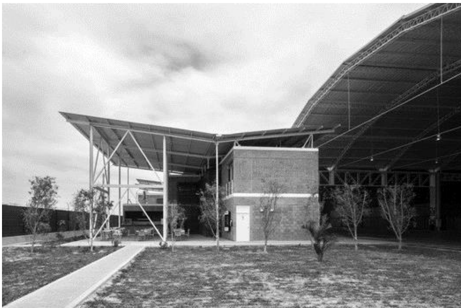
Figura 4: Estrategias aplicadas en hangar- oficinas Fuente: Tomado de www.archdaily.pe/ C.D. Backus.
