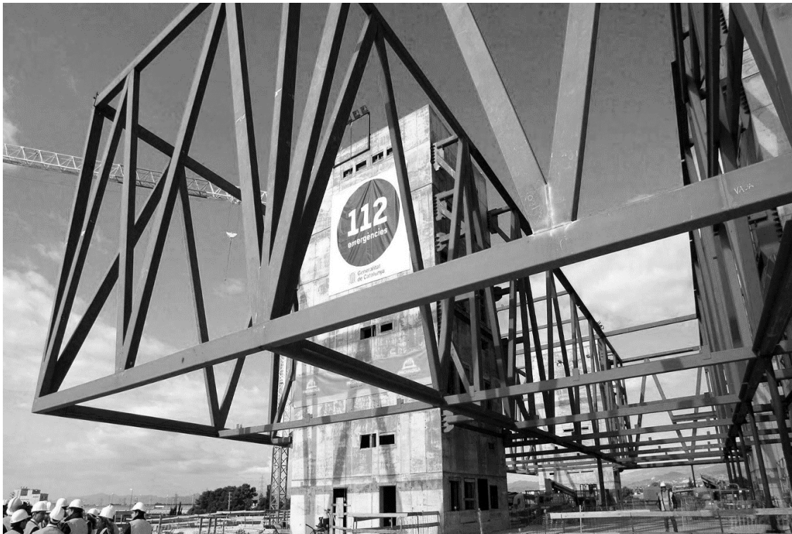
Figura 13: Vista general de la estructura metálica en la fase final de su ejecución Fuente: Tomado de http://laformamodernaenlatinoamerica.blogspot.com
