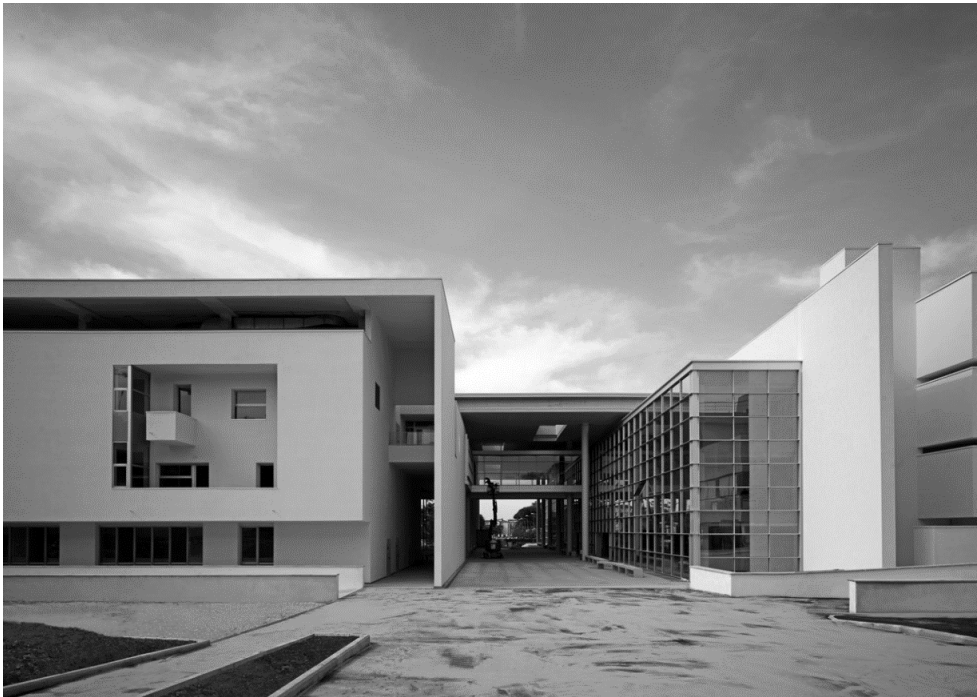
Figura 16: Vista frontal del nuevo espacio integrador Fuente: Tomado de www.archdaily.pe/hospital Careggi/Florenca .
