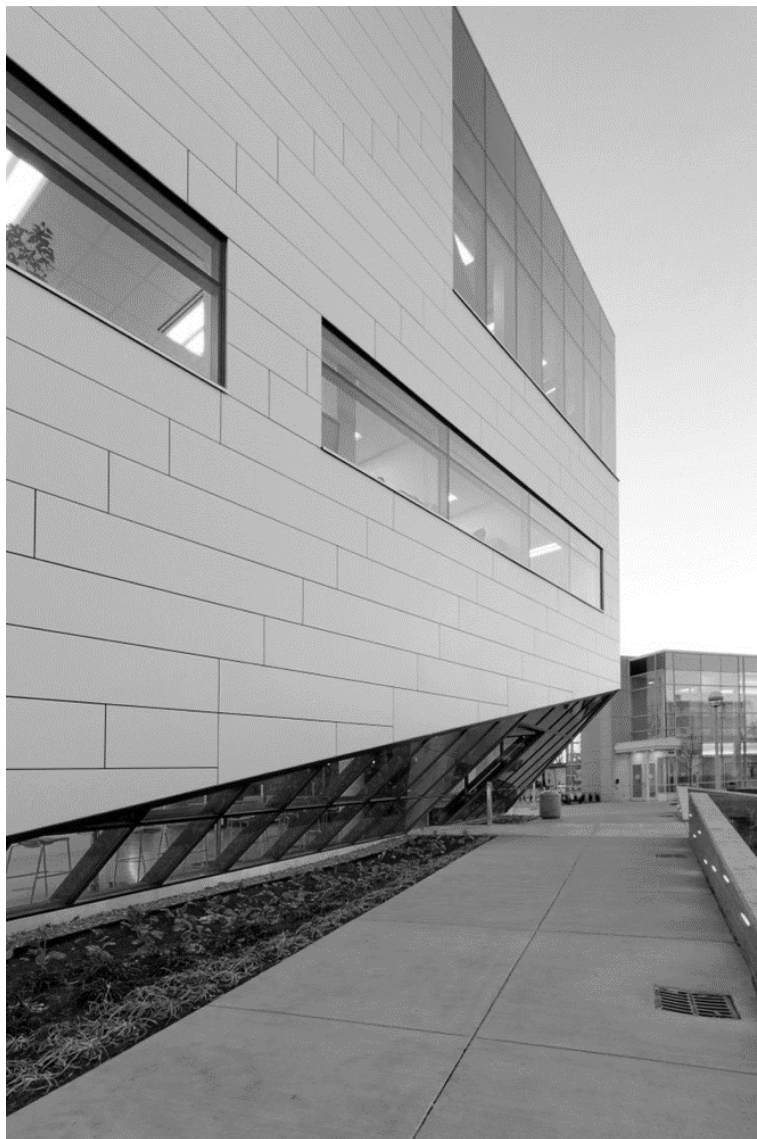
Figura 5: Ingreso Principal al edificio al Centro de Salud Fuente: Tomado de www.archdaily.pe/infraestructuras hospitalarias .
