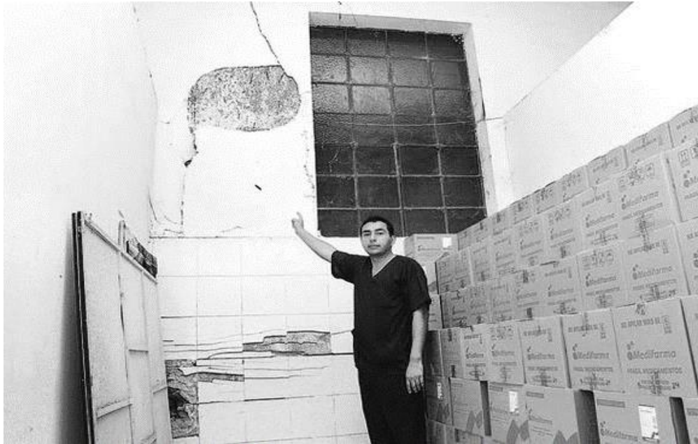
Figura 44: Pabellón de Medicina Física y Rehabilitación en pésimas condiciones Fuente: Tomada https://larepublica.pe//sociedad
