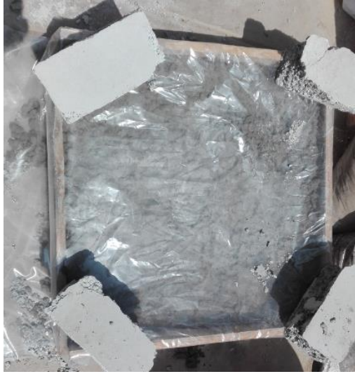
Figura 30. Curado de la losa de concreto
