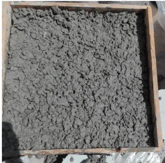
Figura 29. Elaboración de una losa de concreto de 10 cm de altura
