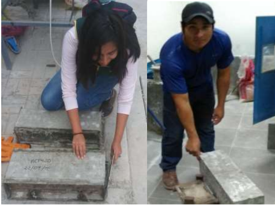
Figura 73. Desencofrado de vigas de concreto
