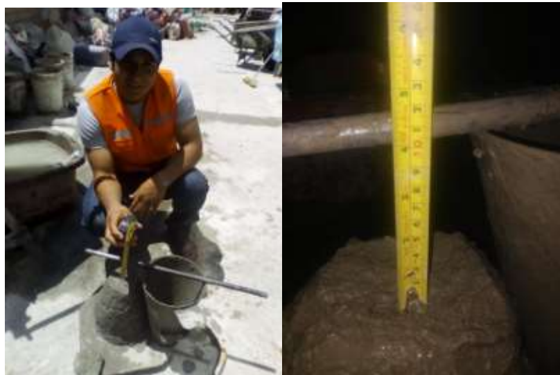
Figura 10. Medición de Asentamiento del concreto con aditivo en estado fresco Fuente Elaboración propia
