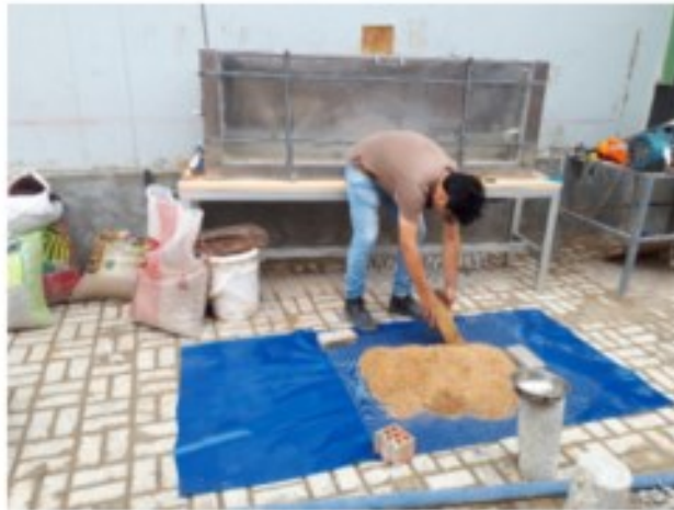
Figura. 2.6 Tamizado de la arena gruesa con malla metálica de \frac{1}{4} ". Fuente: Elaboración propia
