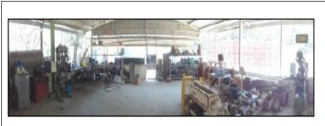
Figura 48: Vista panorámica del taller eléctrico
