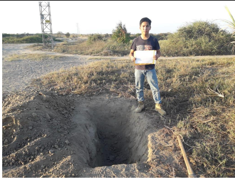
Figura 69. Extracción de muestra. Calicata Ferreñafe 2
