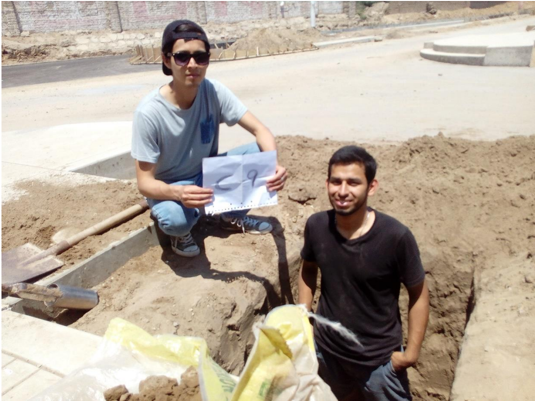
Fotografía N° 01: Exploración de las calicatas
