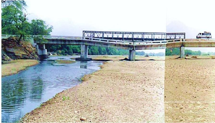
**Figura 2:** Pilares que fallaron por el fenómeno del 98 y se instaló un puente Bailey que se apoya en los pilares
