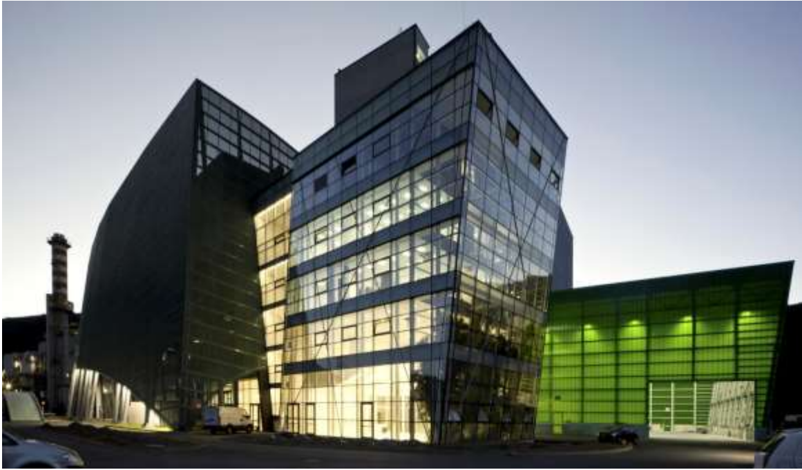
Figura 50: Planta de tratamiento “WtE” en Bolzano, Italia Fuente: ArchDaily
