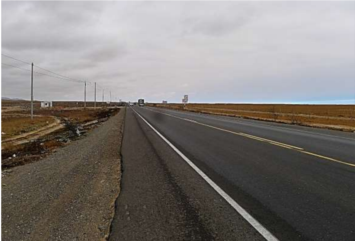
Figura 64: Carretera Panamericana Norte Fuente: Trabajo de campo
