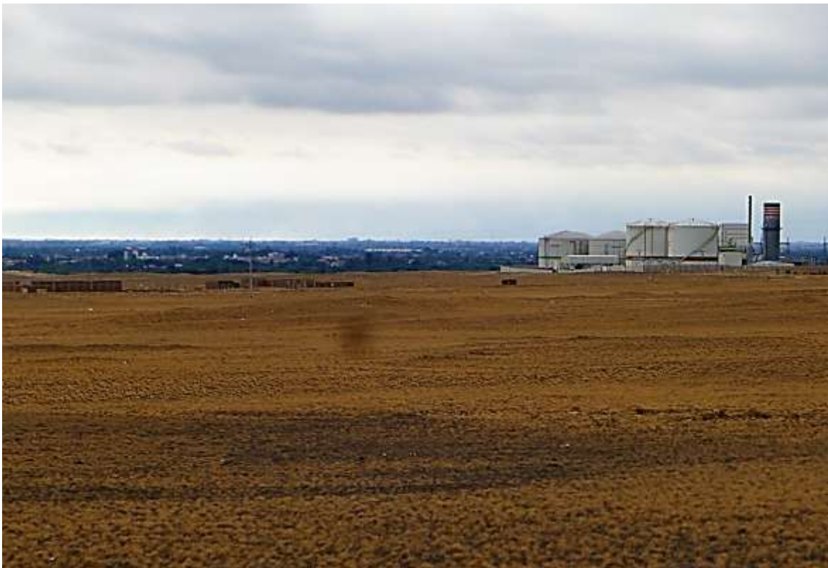
Figura 65: Central Termoeléctrica RECKA Fuente: Trabajo de campo
