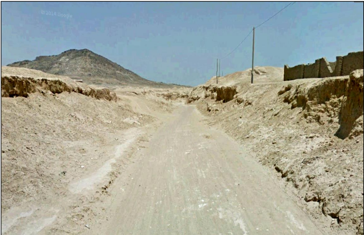
Anexo 1. Inicio de formación de los taludes Progresiva 0 + 050 m.
