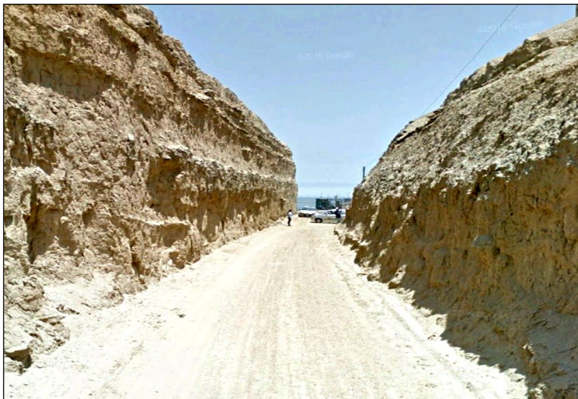
Anexo 1. Inicio de formación de los taludes Progresiva 0 + 440 m.
