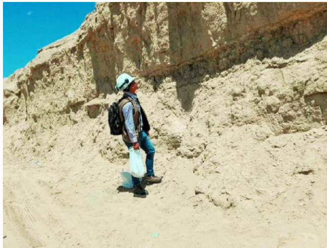
Ilustración 18. Observación de falla de talud
