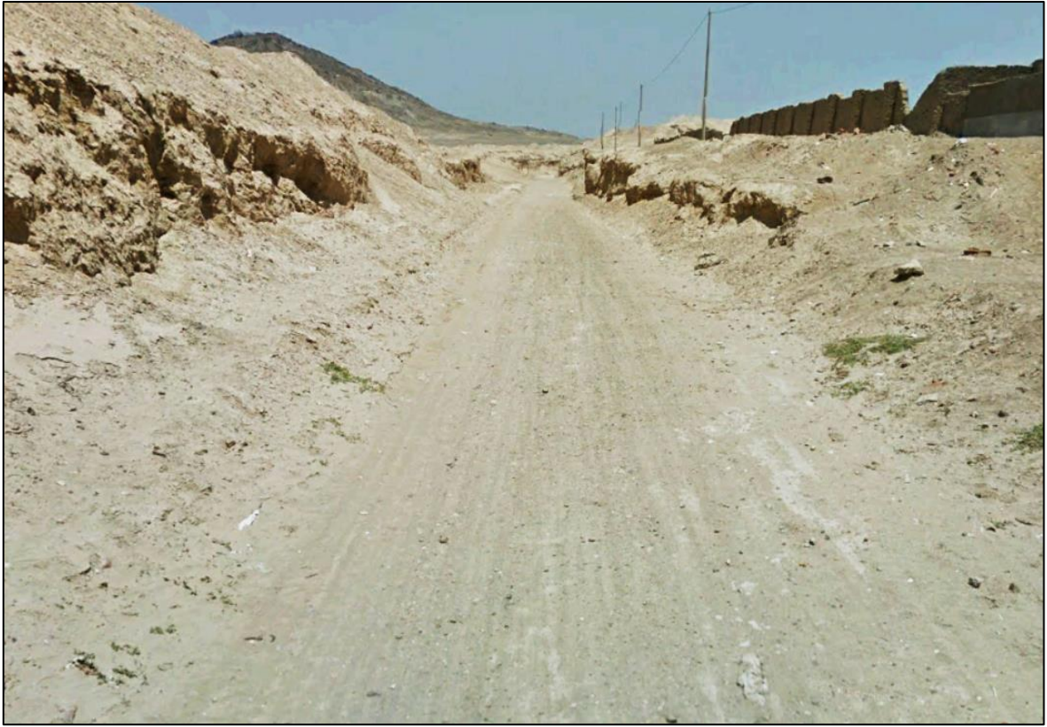
Anexo 1. Inicio de formación de los taludes Progresiva 0 + 000 m.
