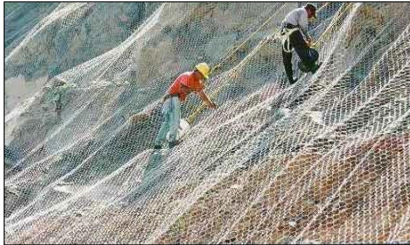
Ilustración 8. Uso de mallas de acero (Corral Higuera, 2006)
