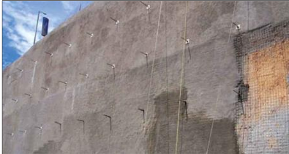
Ilustración 6. Concreto lanzado (shotcrete) (Corral Higuera, 2006)
