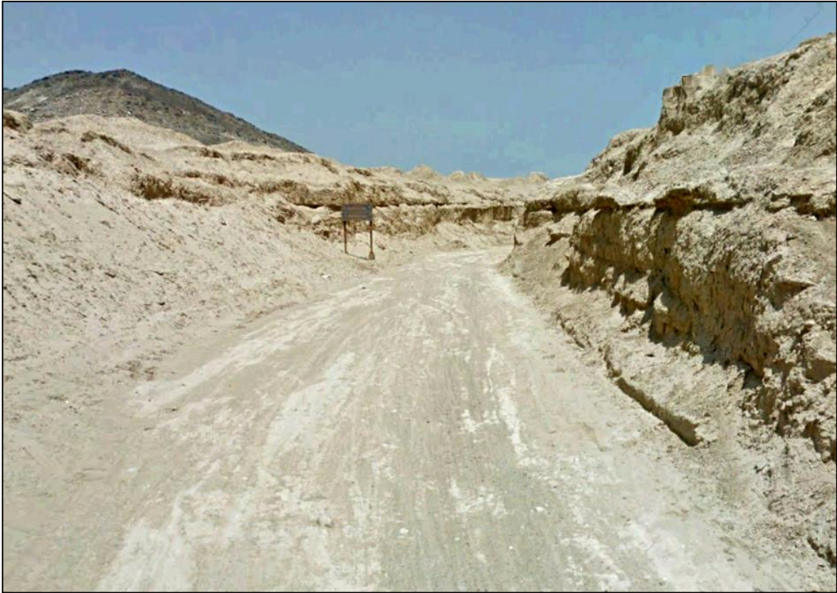
Anexo 1. Inicio de formación de los taludes Progresiva 0 + 080 m.
