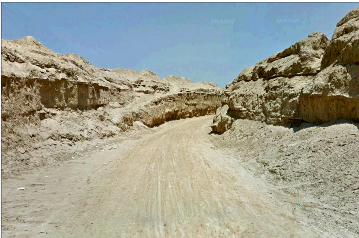
Anexo 1. Inicio de formación de los taludes Progresiva 0 + 150.
