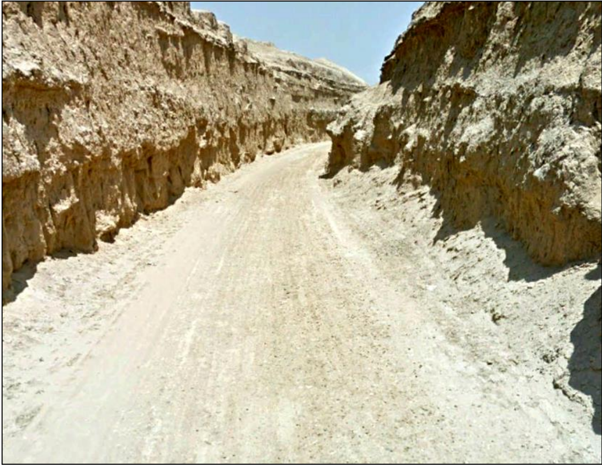
Anexo 1. Inicio de formación de los taludes Progresiva 0 + 250 m.
