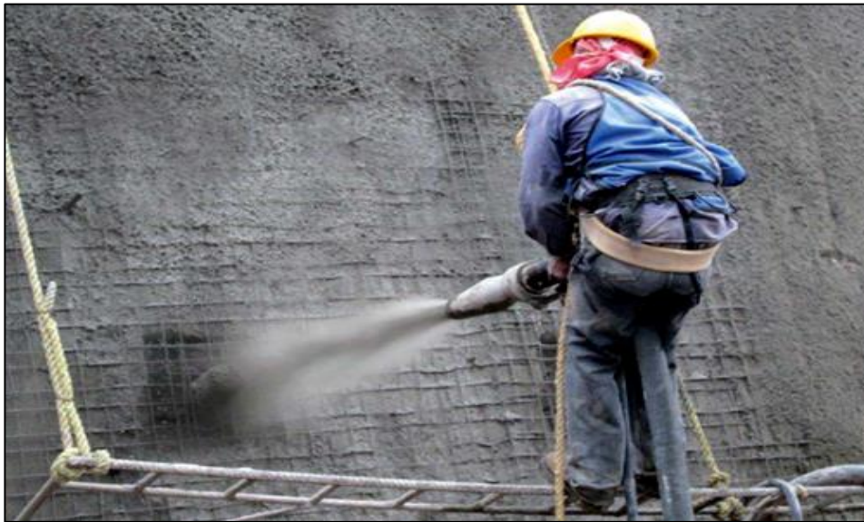
Ilustración 7. Concreto lanzado (shotcrete) (Corral Higuera, 2006)
