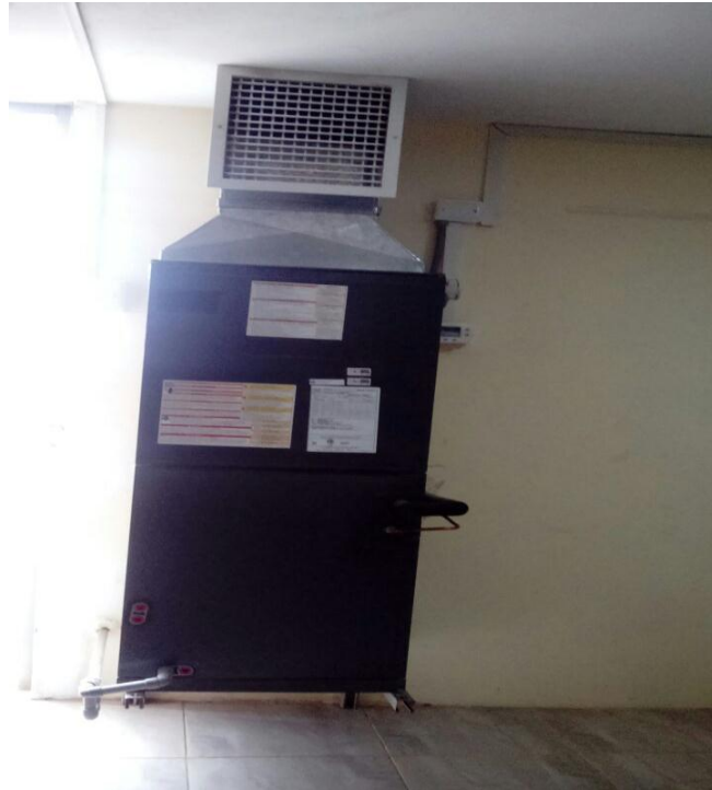
Figura 5: Mantenimiento de equipos de Banda Ancha
