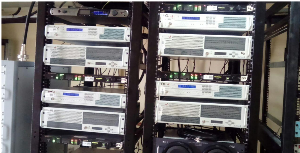
Figura 6: Mantenimiento de Servidor de Datos
