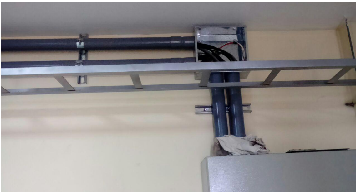
Figura 4: Instalación de Sistemas de datos de información
