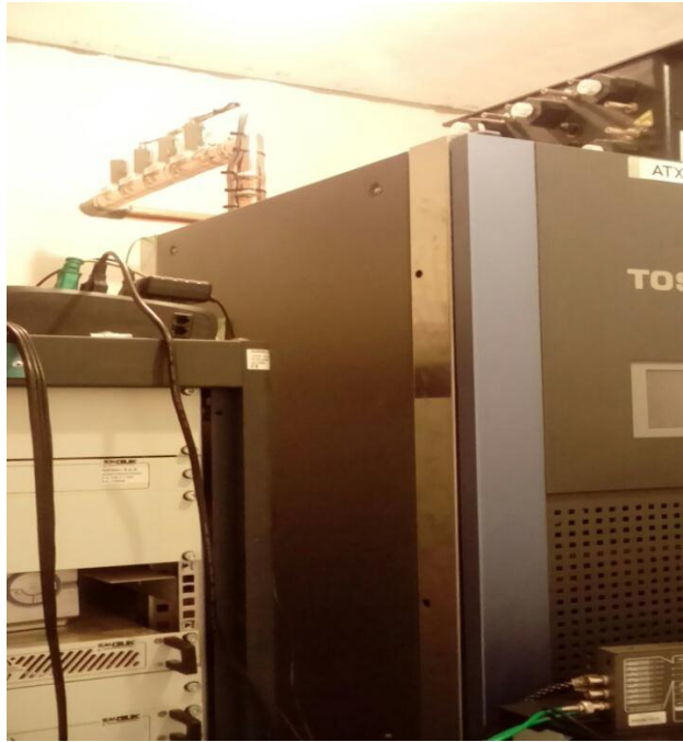
Figura 7: Mantenimiento de Servidor de Datos de Bancos
