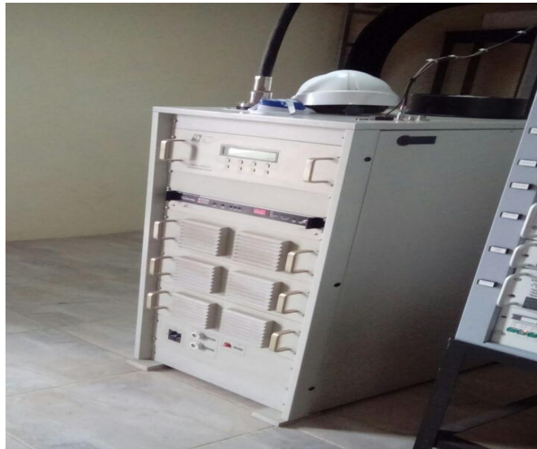
Figura 2: Mantenimiento de equipos de comunicación
