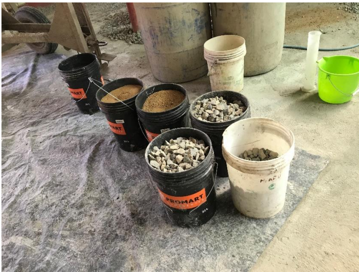
Materiales pesados para una tanda de concreto.
