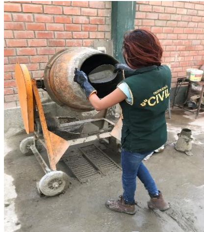
Figura 13. Extrayendo mezcla de concreto de mezcladora tipo trompo.
