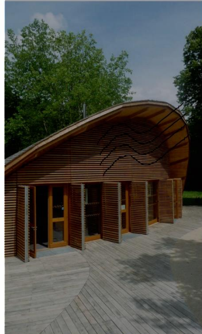
Cerramiento para ventilación
